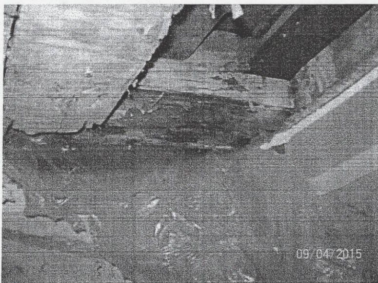
Fot.6. Fragment odkrytej belki stropowej w pomieszczeniu piwnicznym nr 5.
