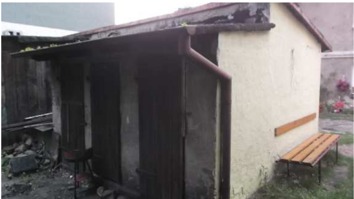
fot. nr 2 Sąsiadujący budynek gospodarczy murowany – przewidziany do pozostawienia.
