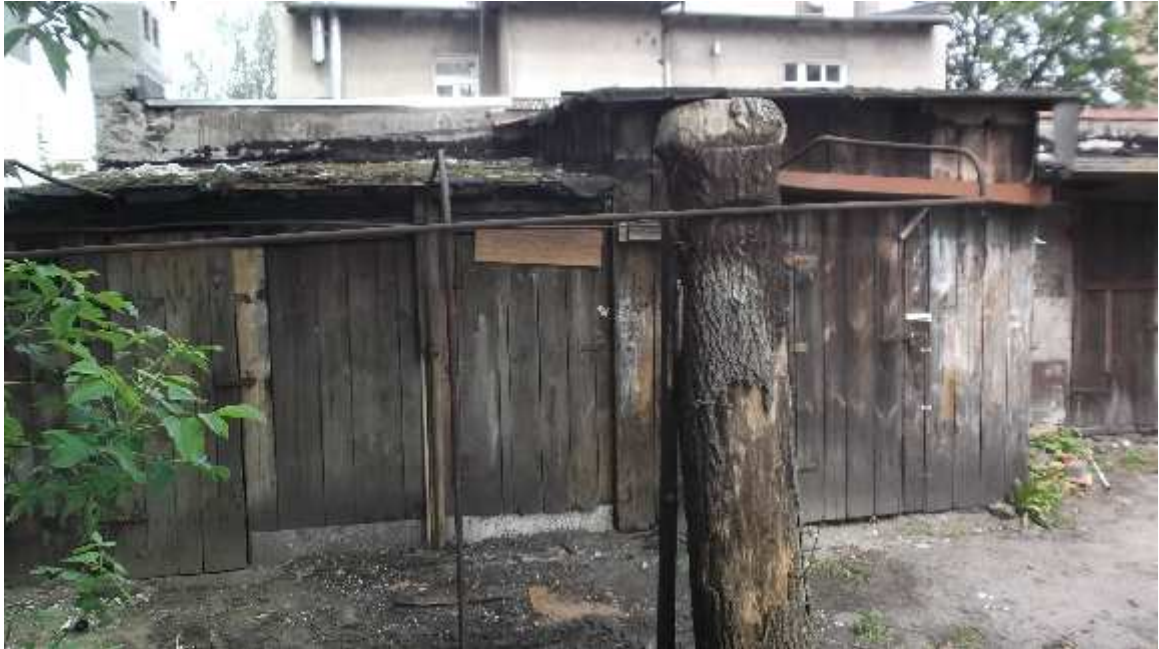
fot. nr 1 Widok ogólny obiektu – budynki drewniane przeznaczone do rozbiórki.
