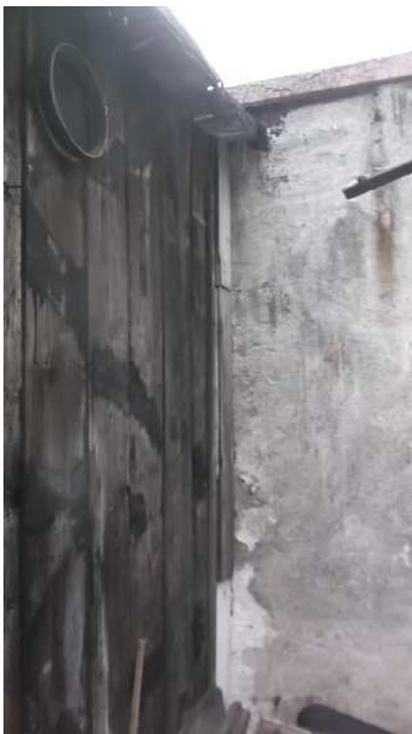
fot. nr 6 połączenie ściany zewnętrznej budynku przewidzianego do rozbiórki z ścianą zewnętrzną budynku gospodarczego murowanego przewidzianego do pozostawienia.
