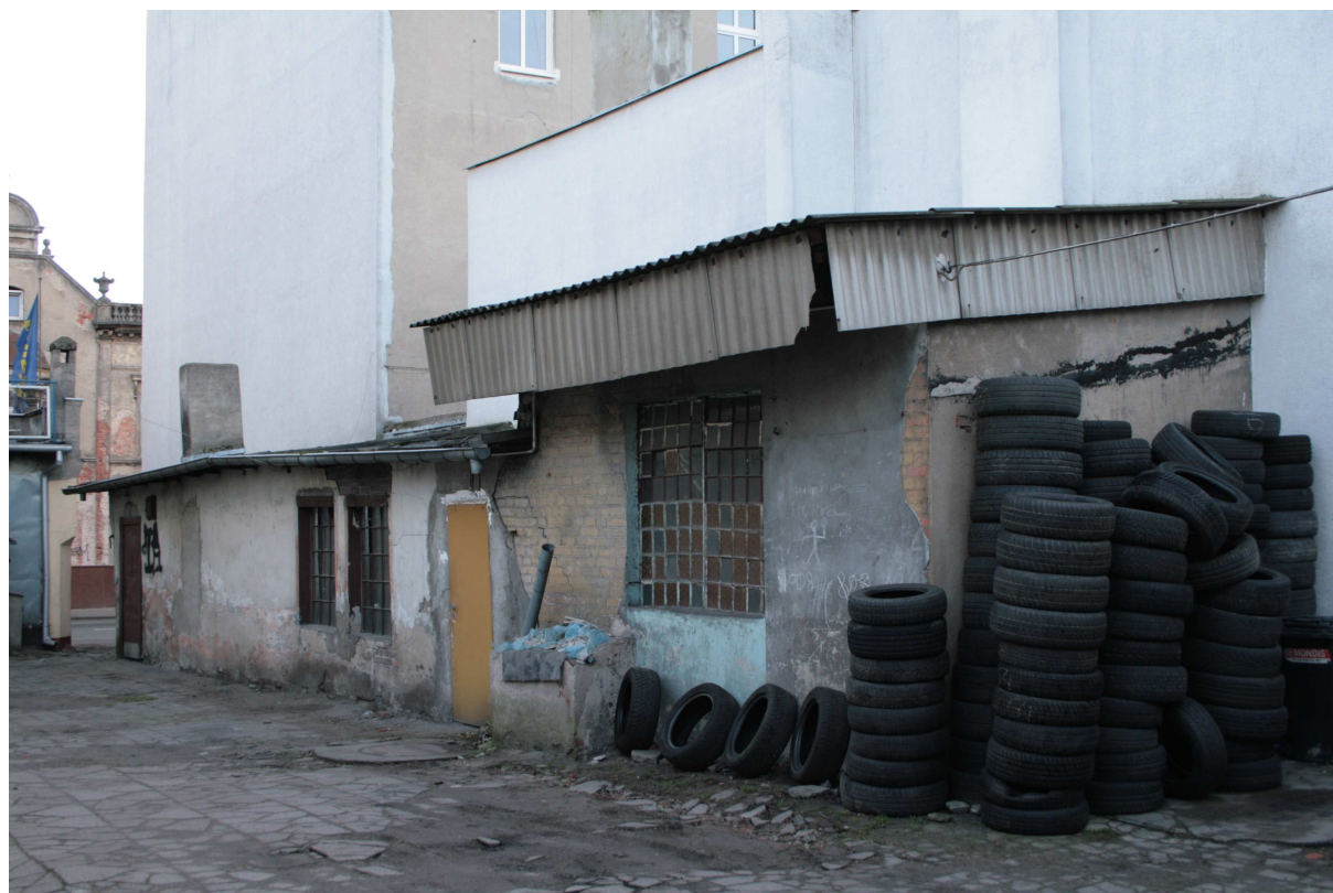
Budynek użytkowy (L-304) i budynek gospodarczy ul. Królowej Jadwigi 11, Bydgoszcz
