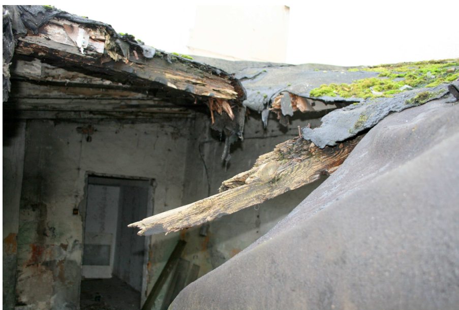
Stan dachu w budynku o pokryciu papowym (wnętrze)
