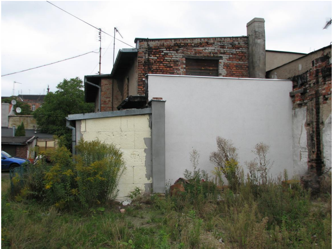
Foto.3 Budynek oficyny - widok na ścianę szczytową
