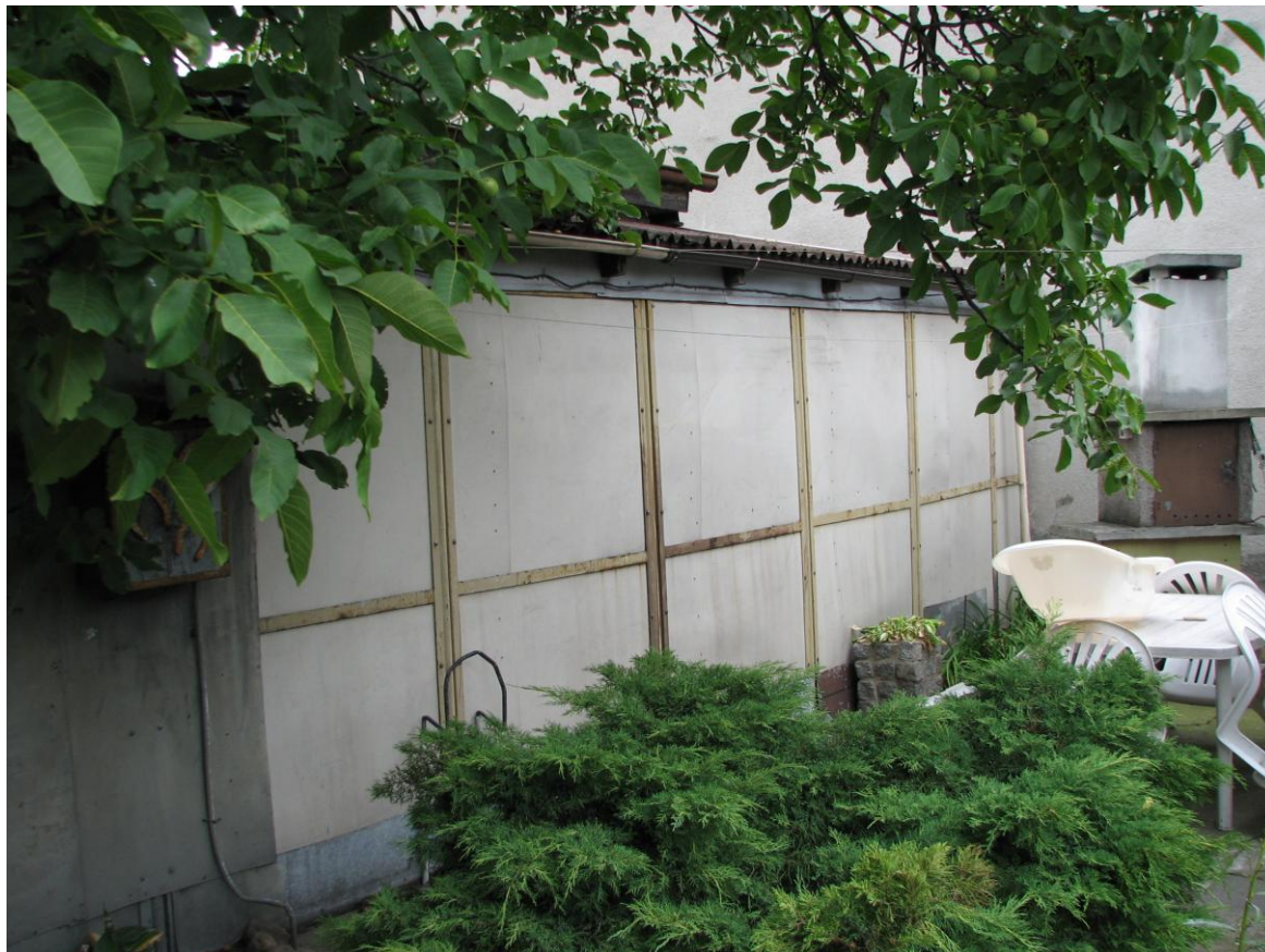
Foto.12 Sklep – widok od strony tylnej
