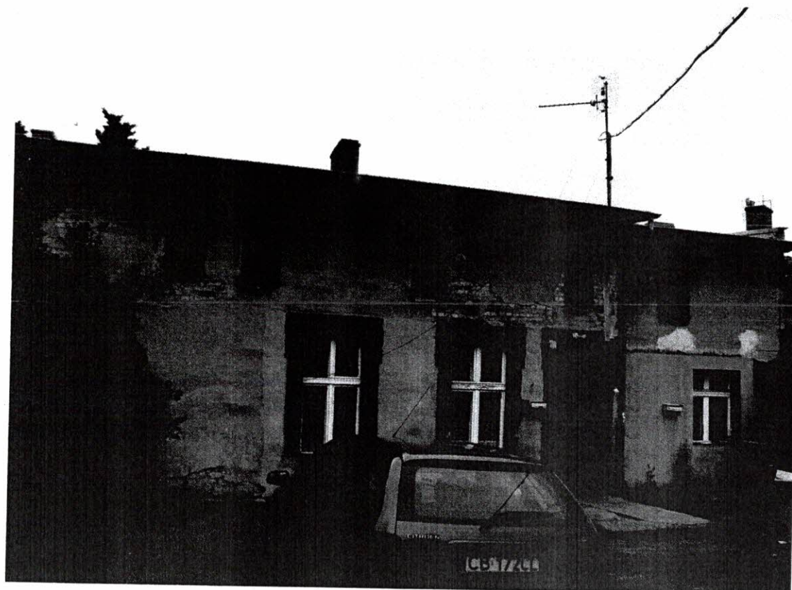
Foto.2 Budynek oficyny - widok od frontu
