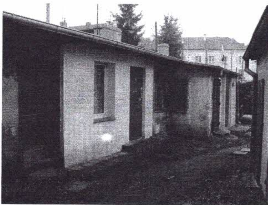
Elewacja północna – frontowa.
