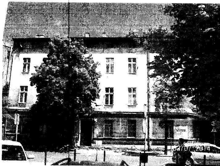
Fot. 1. Elewacja frontowa budynku od strony ul. Sowińskiego.
