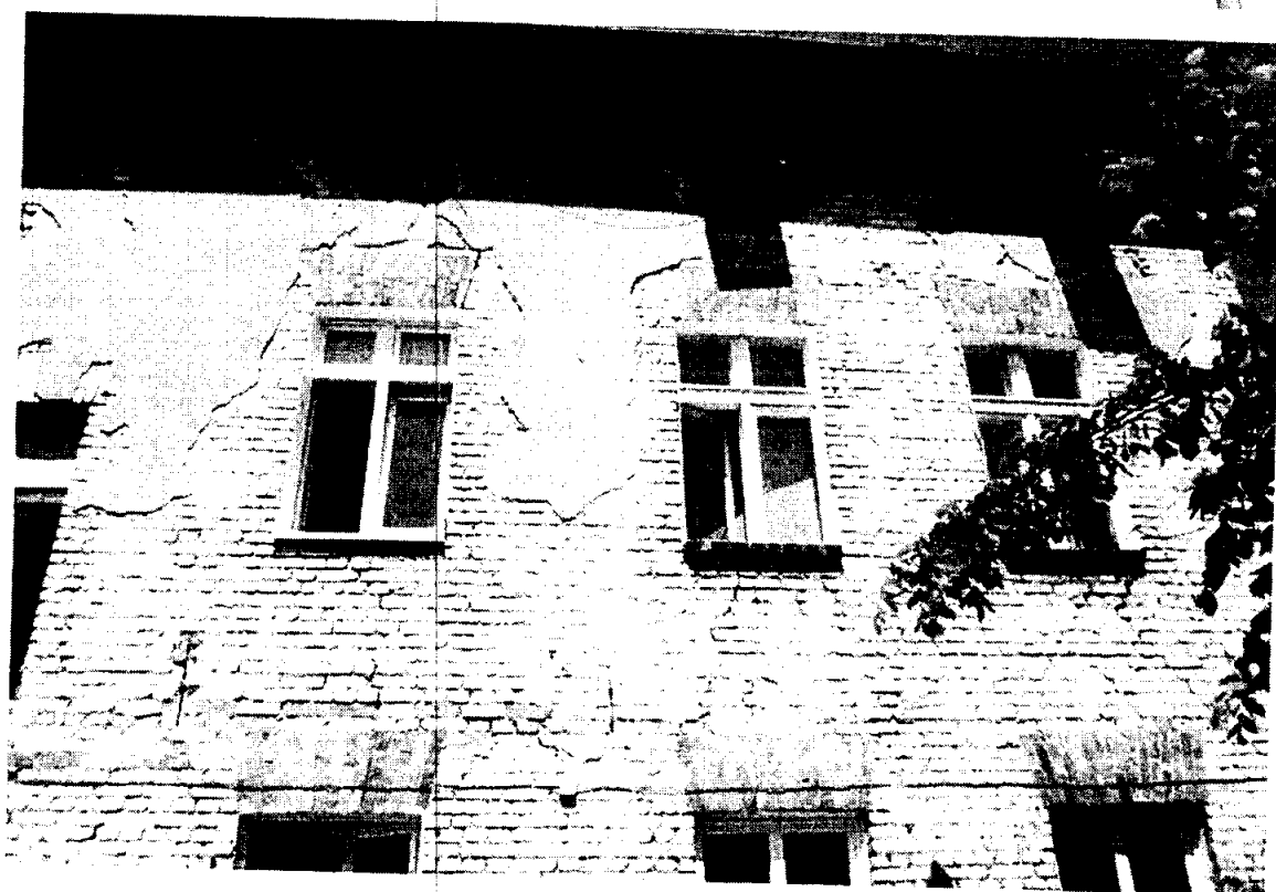
Fot. 7 i 8. Stan spękań ścian piętra budynku 2c od strony podwórza (południowej).
