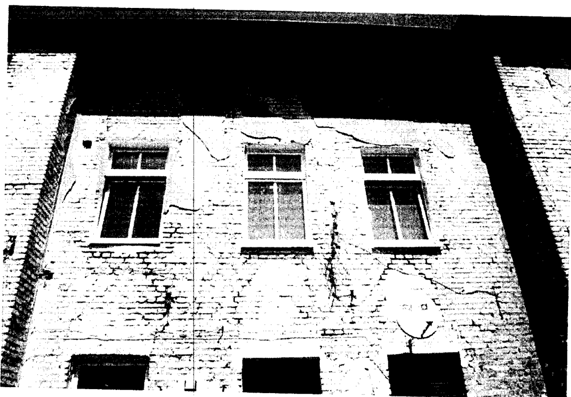
Fot. 5 i 6. Stan spękań ścian piętra budynku 2b od strony podwórza (południowej).
