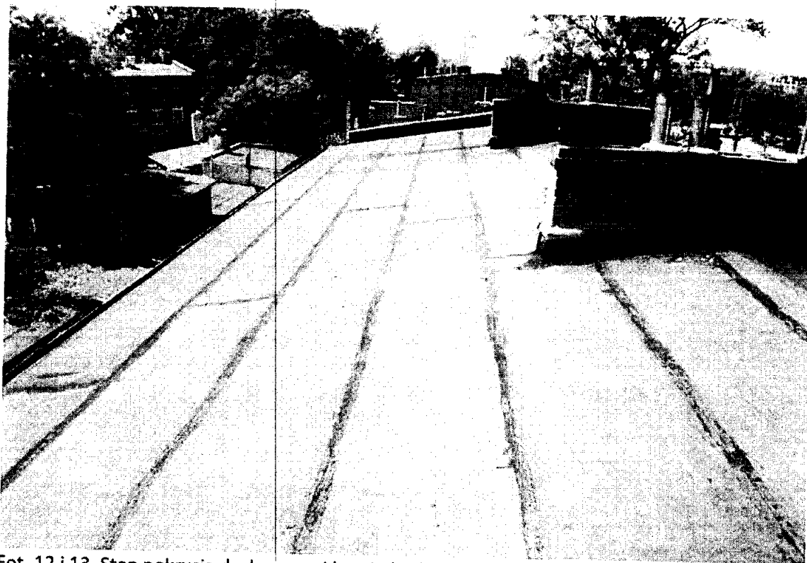
Fot. 12 i 13. Stan pokrycia dachowego i kominów (u góry na styku budynków).
