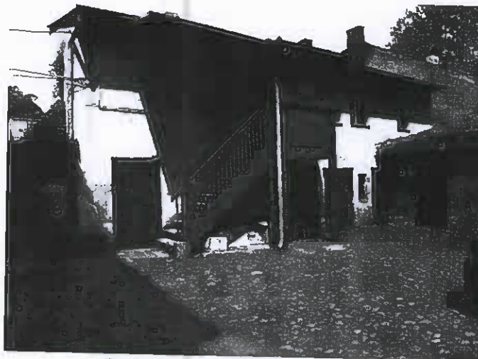
Budynek mieszkalny – oficyna
