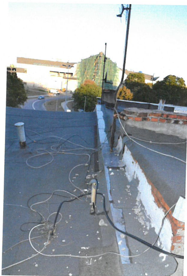
fot. 16. Attyka przy budynku sąsiednim na działce nr 11/1.
