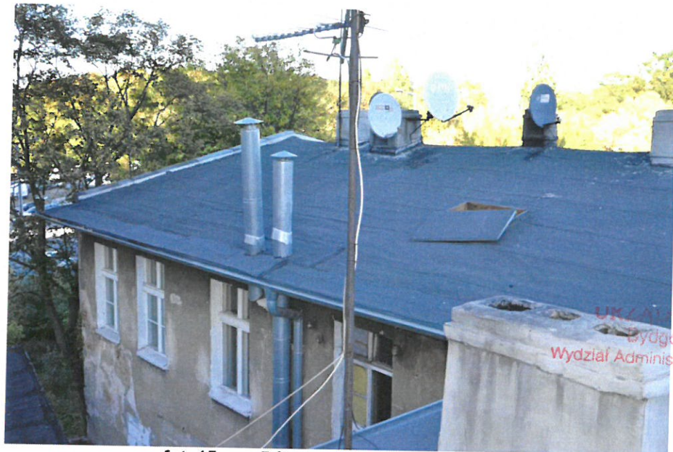
fot. 15. Północna część dachu.
