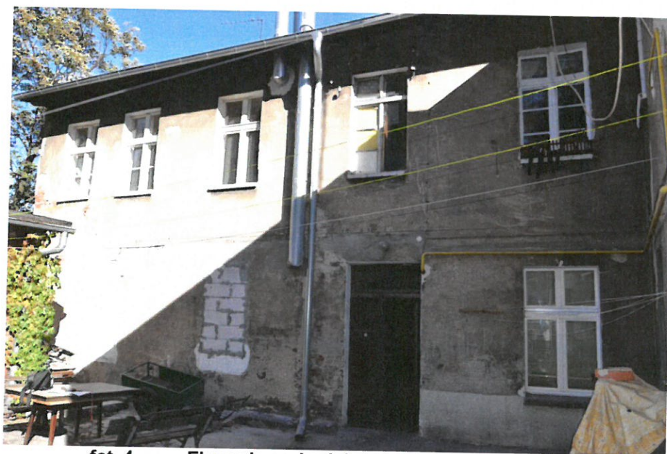
fot. 4. Elewacja zachodnia od strony podwórza.
