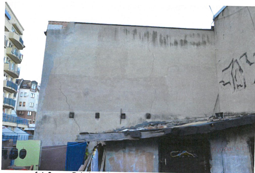
fot. 3. Pęknięcie ściany od strony południowej.
