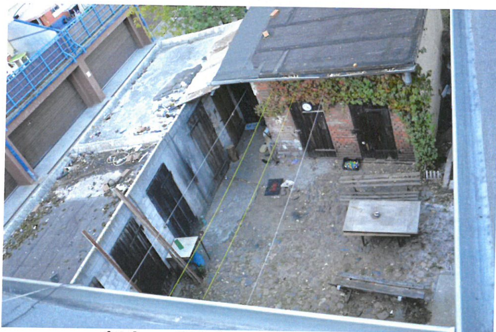
fot. 6. Podwórze – widok z dachu.
