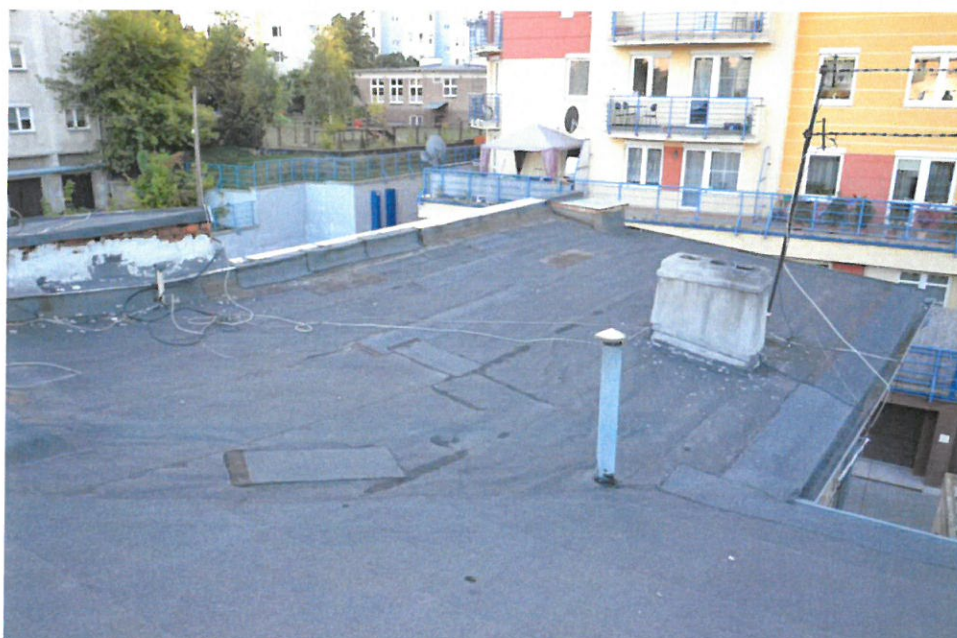
fot. 14. Zachodnia część dachu.
