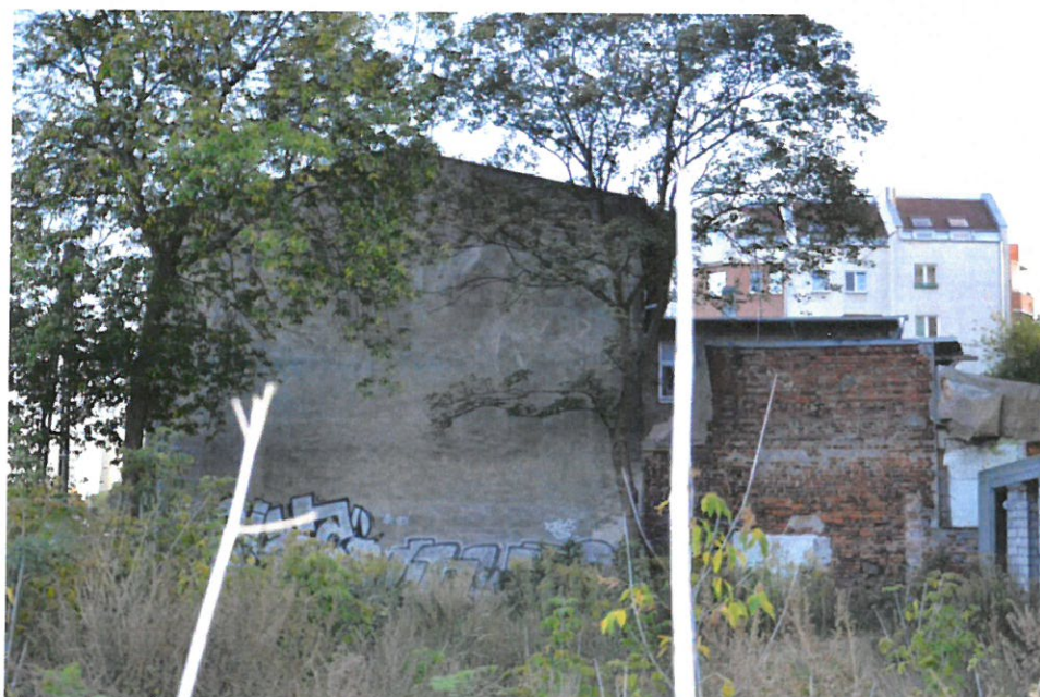
fot. 2. Elewacja od strony północnej.
