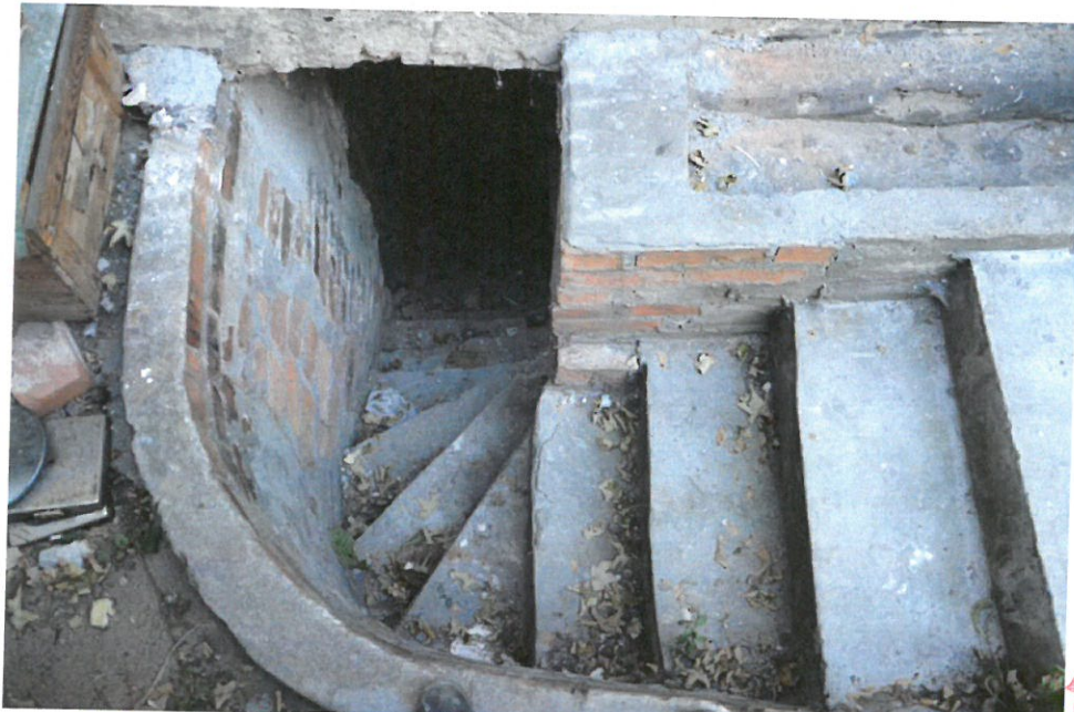
fot. 7. Wejście do piwnicy od strony podwórza.
