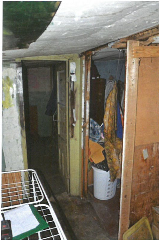
fot. 13. Zachodnia część poddasza.
