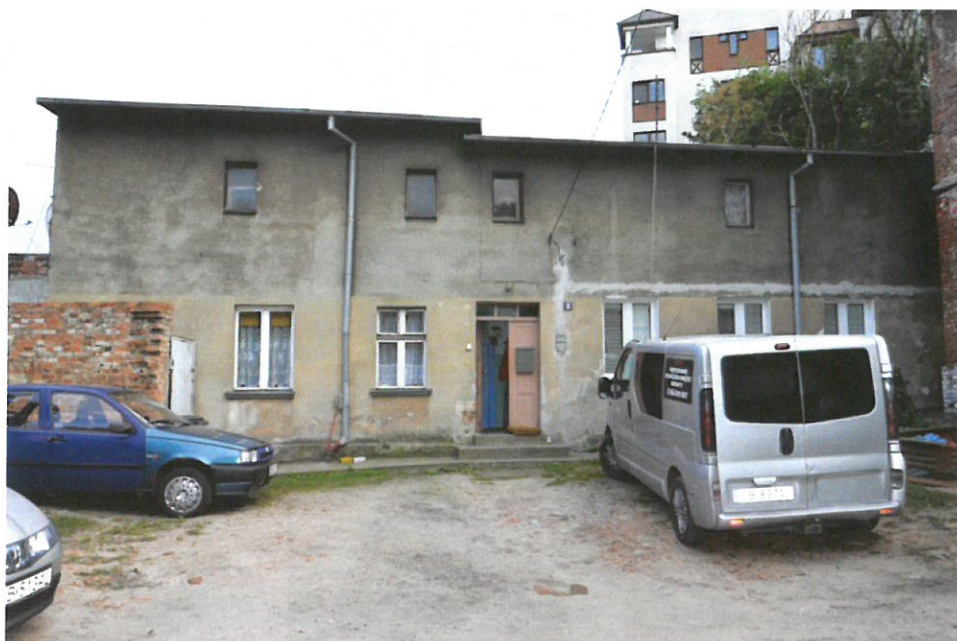
fot. 1. Elewacja od strony północnej.
