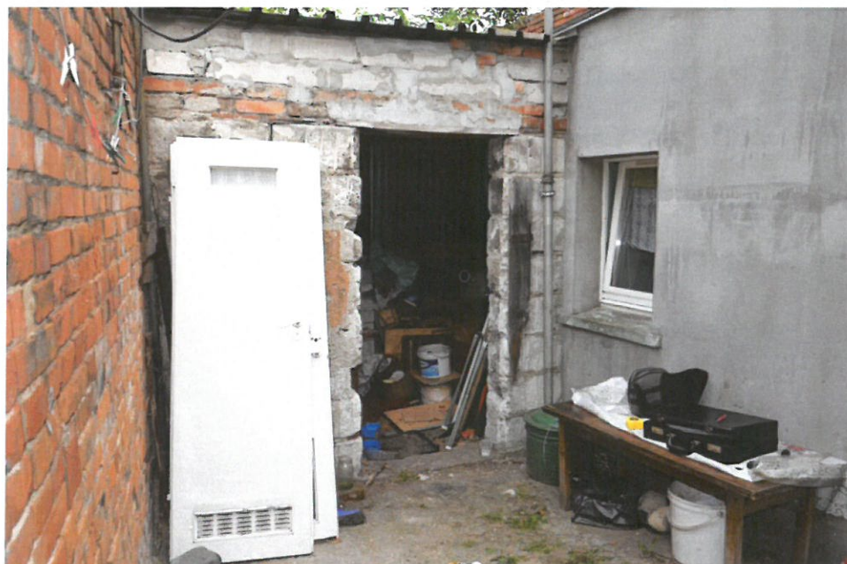
fot. 10. Przybudówka i pomieszczenie gospodarcze od strony wschodniej.
