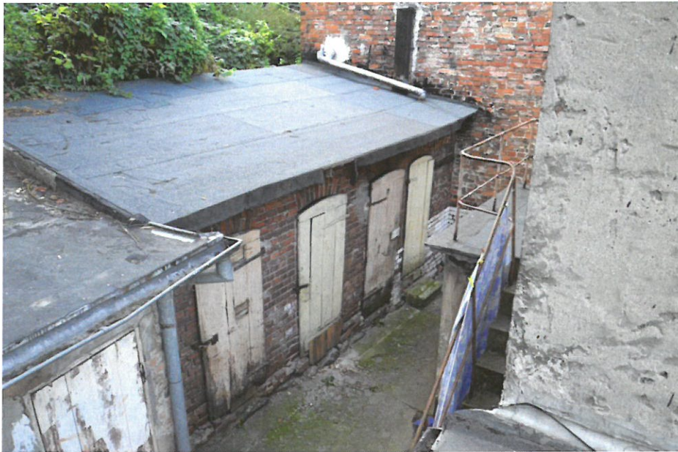
fot. 12. Budynek na działce nr 83 (widok z dachu).
