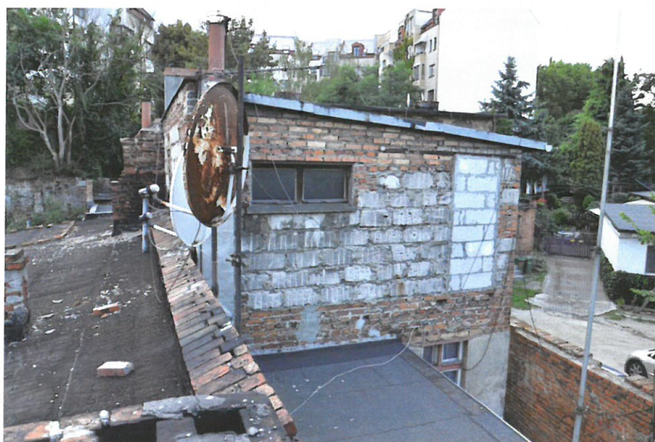
fot. 2. Elewacja od strony wschodniej (widok z dachu).
