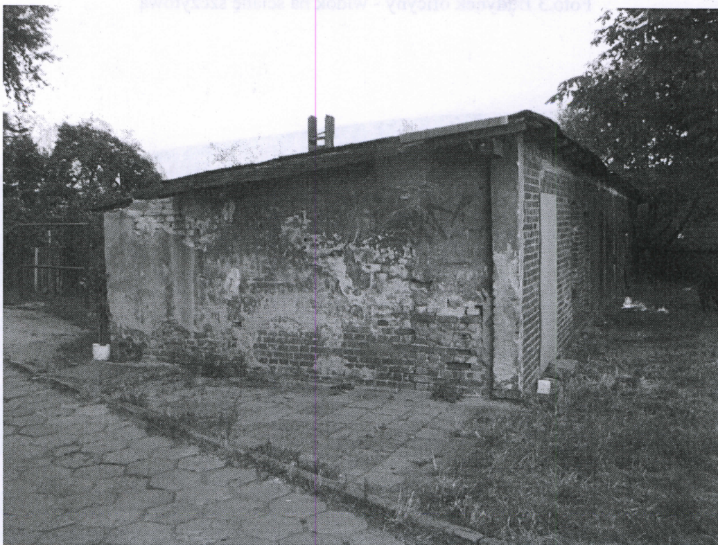
Foto.6 Budynek gospodarczy – widok z boku
