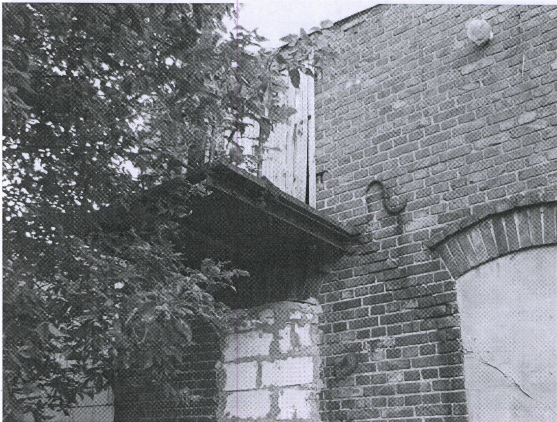
Foto.3 Budynek oficyny - widok na ścianę szczytową
