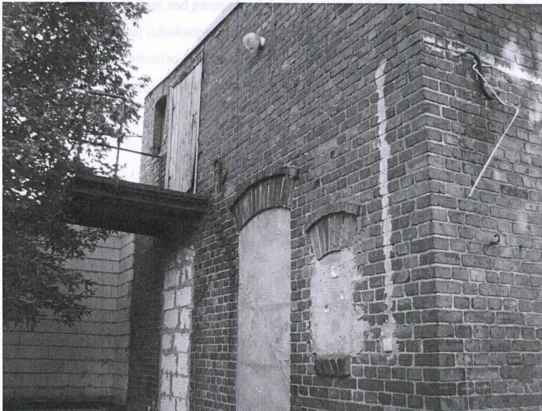
Foto.2 Budynek oficyny - widok na ścianę szczytową
