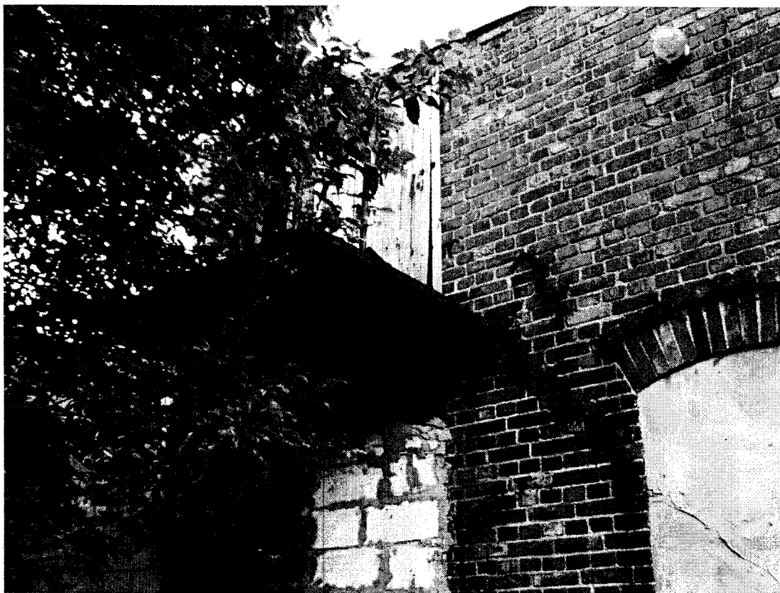
Foto.3 Budynek oficyny - widok na ścianę szczytową
