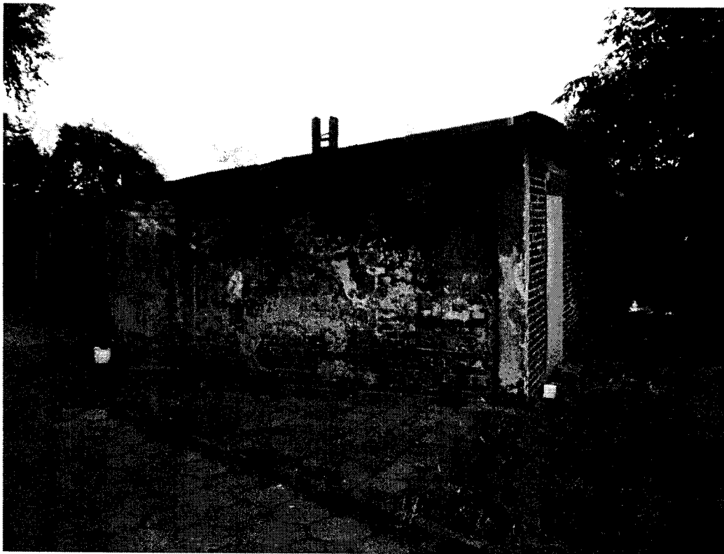
Foto.6 Budynek gospodarczy – widok z boku
