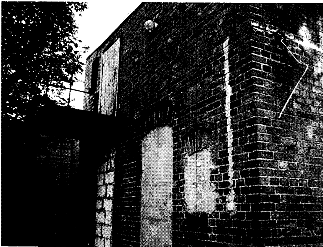
Foto.2 Budynek oficyny - widok na ścianę szczytową
