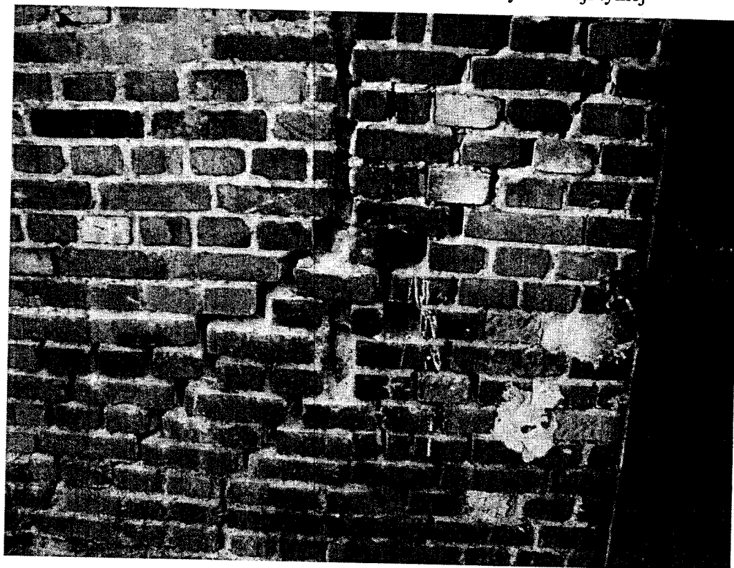
Foto.8 Budynek gospodarczy – popękana ściana od strony frontowej
