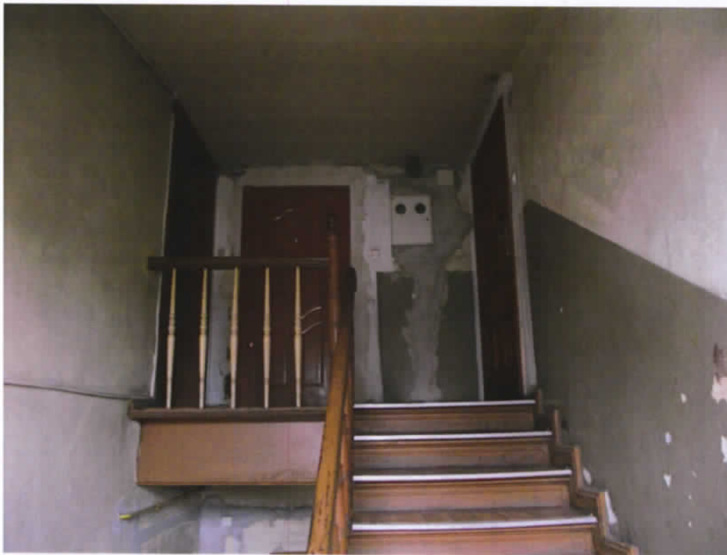
5. Klatka schodowa, trzecie piętro
