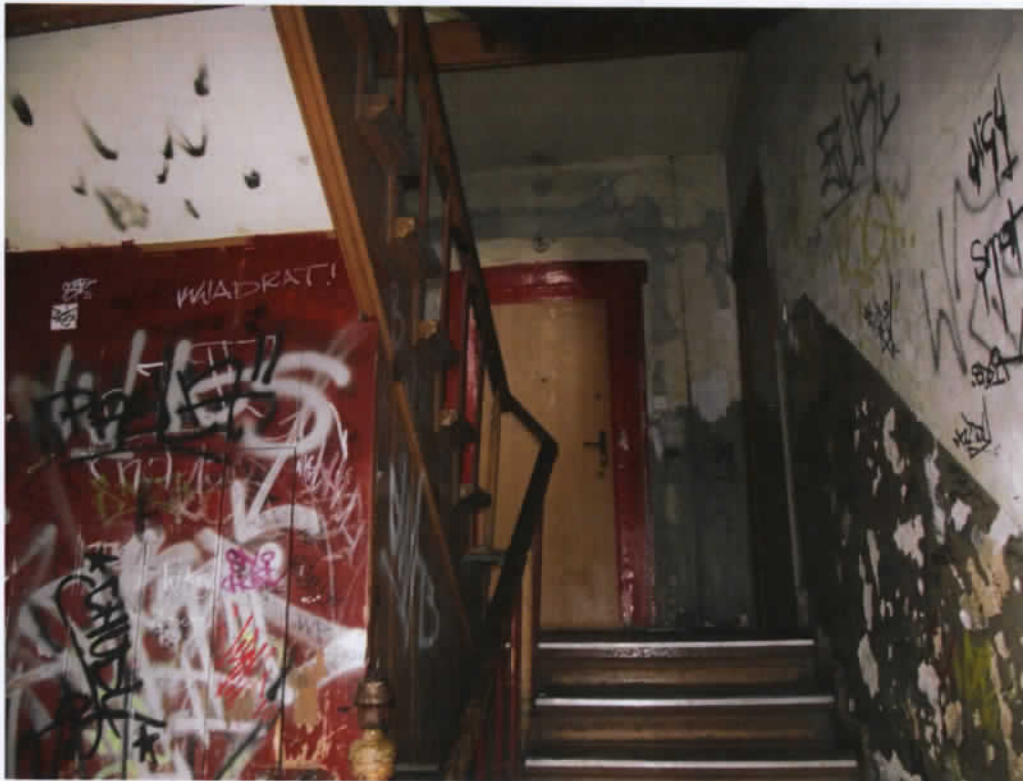
7. Klatka schodowa, pierwsze piętro
