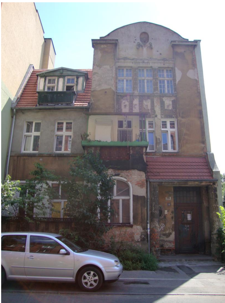
Fot. 1. Zarys ogólny budynku przeznaczanego do termomodernizacji. Widok od frontu.
