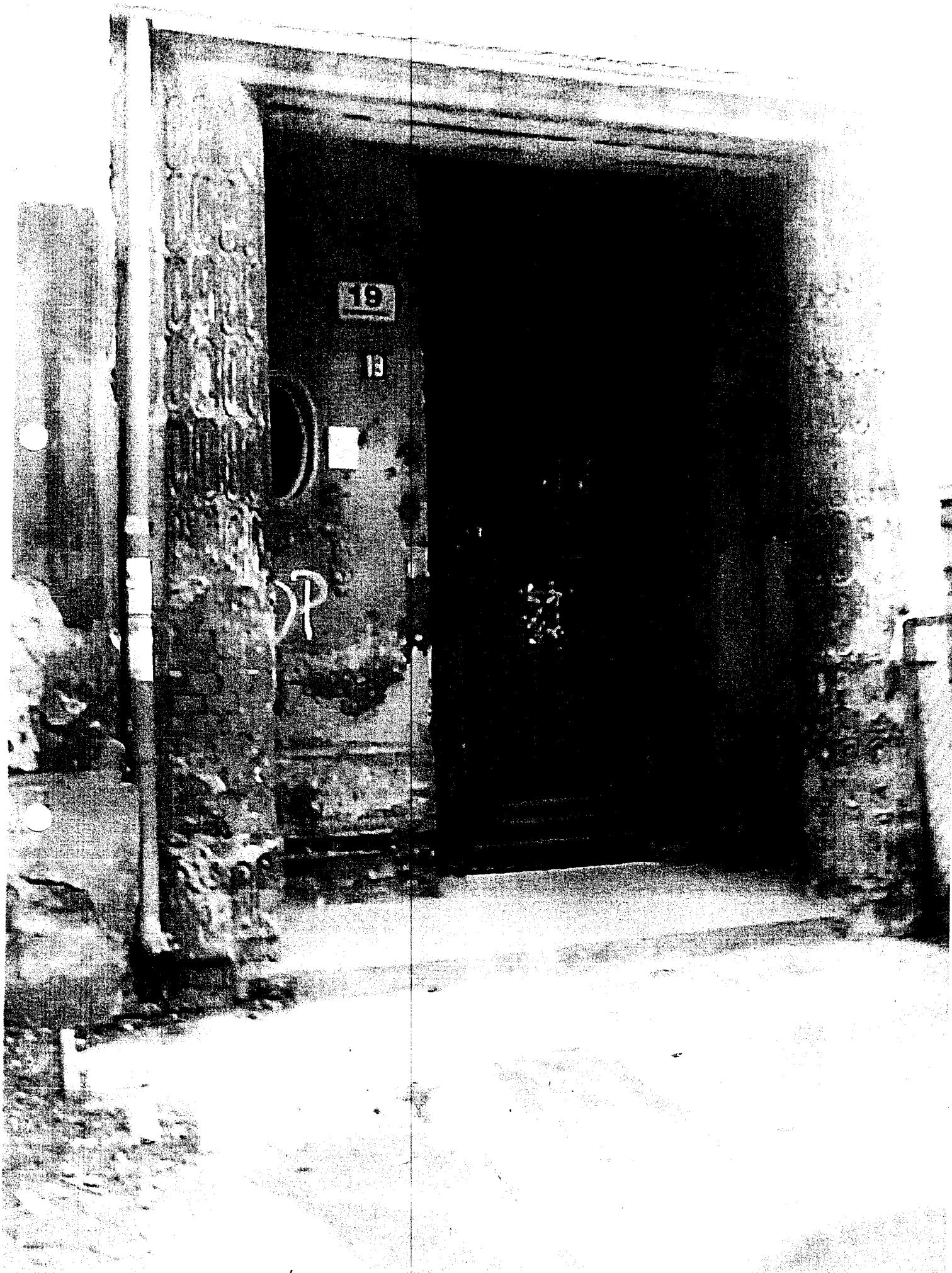
DRZWI WEJŚCIOWE DO BUDYNKU - UBYTKI TYNKU I CEGIEK
