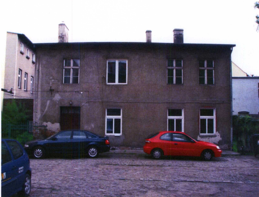
Foto.1 Widok budynku od frontu
