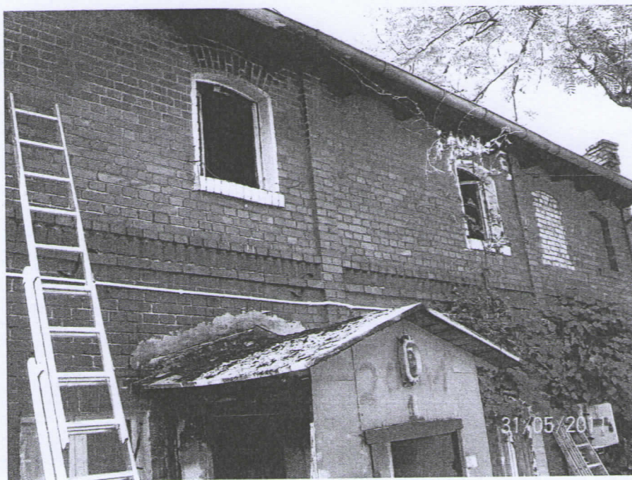
Fot. 1. Fragment elewacji północnej.
