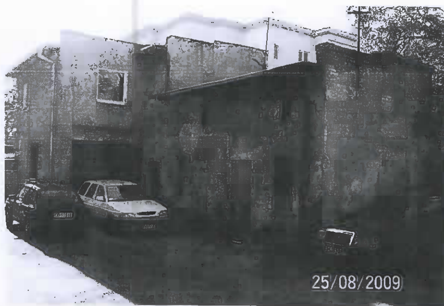
Fot. 1. Elewacja budynku od strony podwórka.
