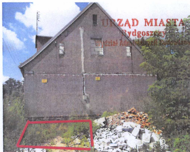
Posadzki betonowe pozostałe porozbiórce budynku gospodarczego Posadzka podlega rozbiórce
