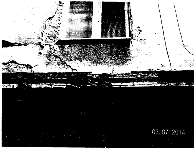
Fot.8. Pęknięcie elewacji frontowej.
