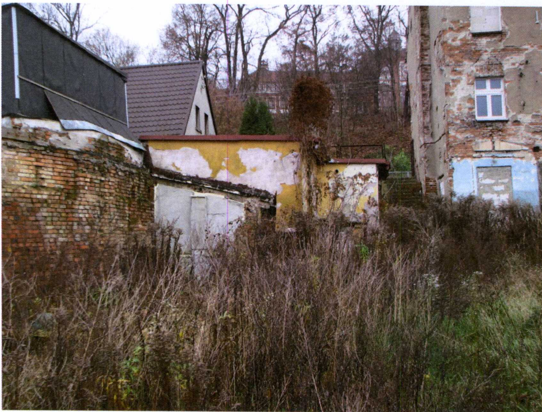
Foto.14 Widok z boku budynku oficyny
