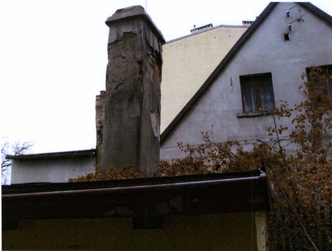
Foto.15 Komin budynku oficyny
