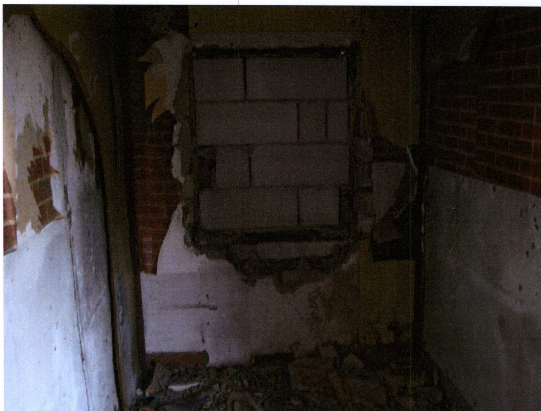
Foto.16 Widok na pokój budynku oficyny
