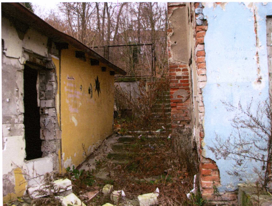
Foto.12 Widok narożnika budynku głównego i budynku oficyny
