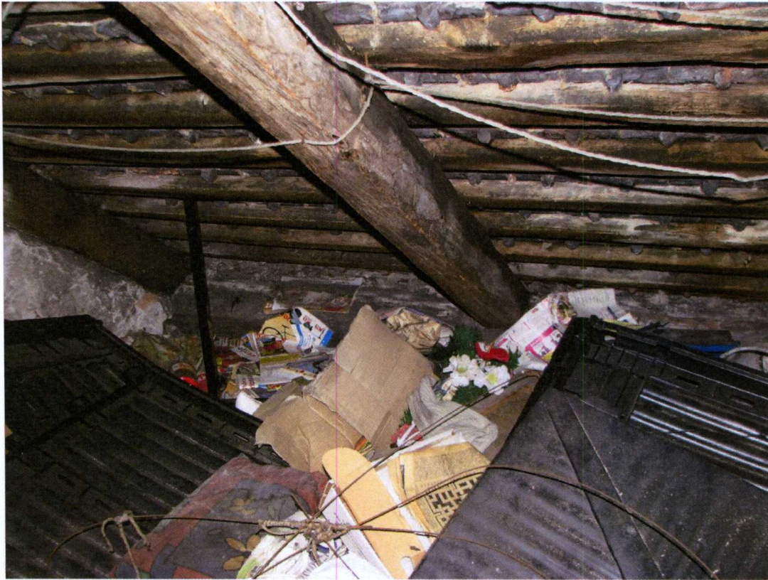
Foto.9 Widok więźby dachowej
