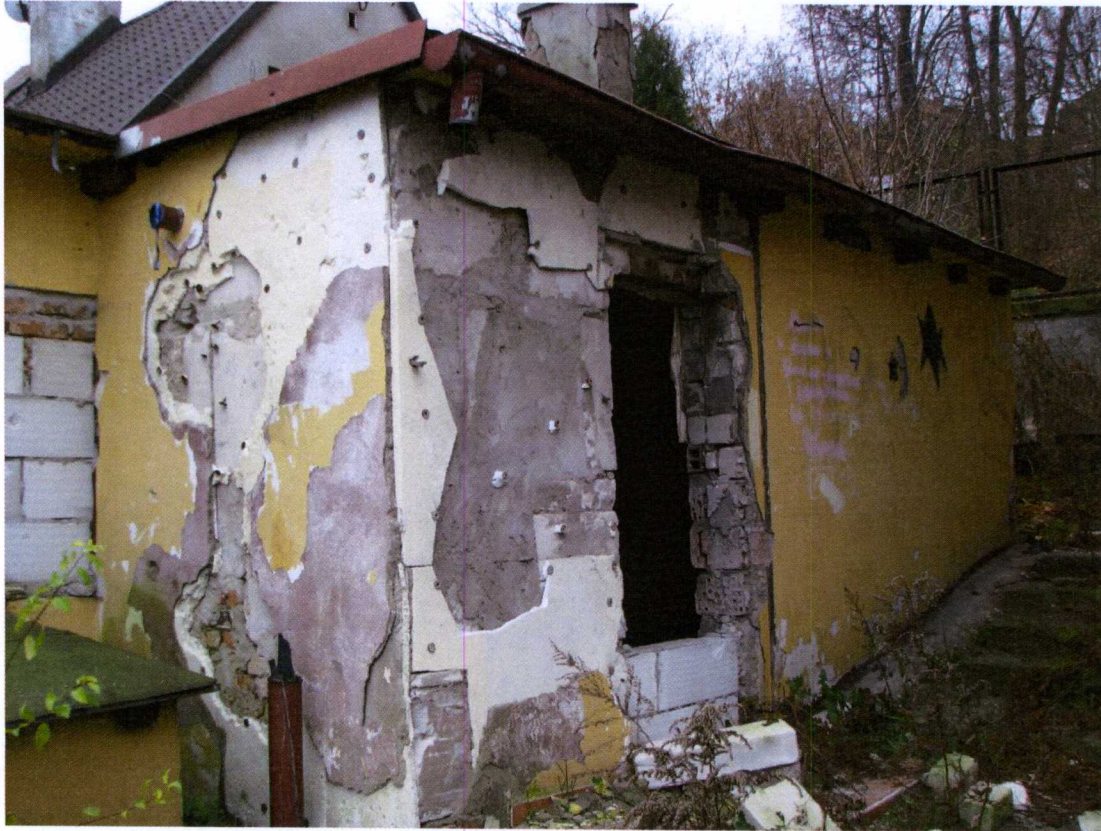
Foto.13 Widok budynku oficyny
