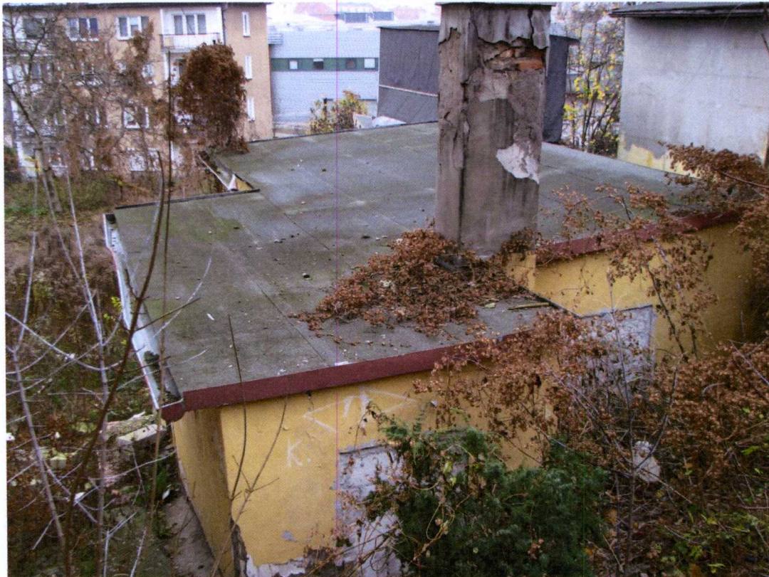
Foto.11 Widok budynku oficyny
