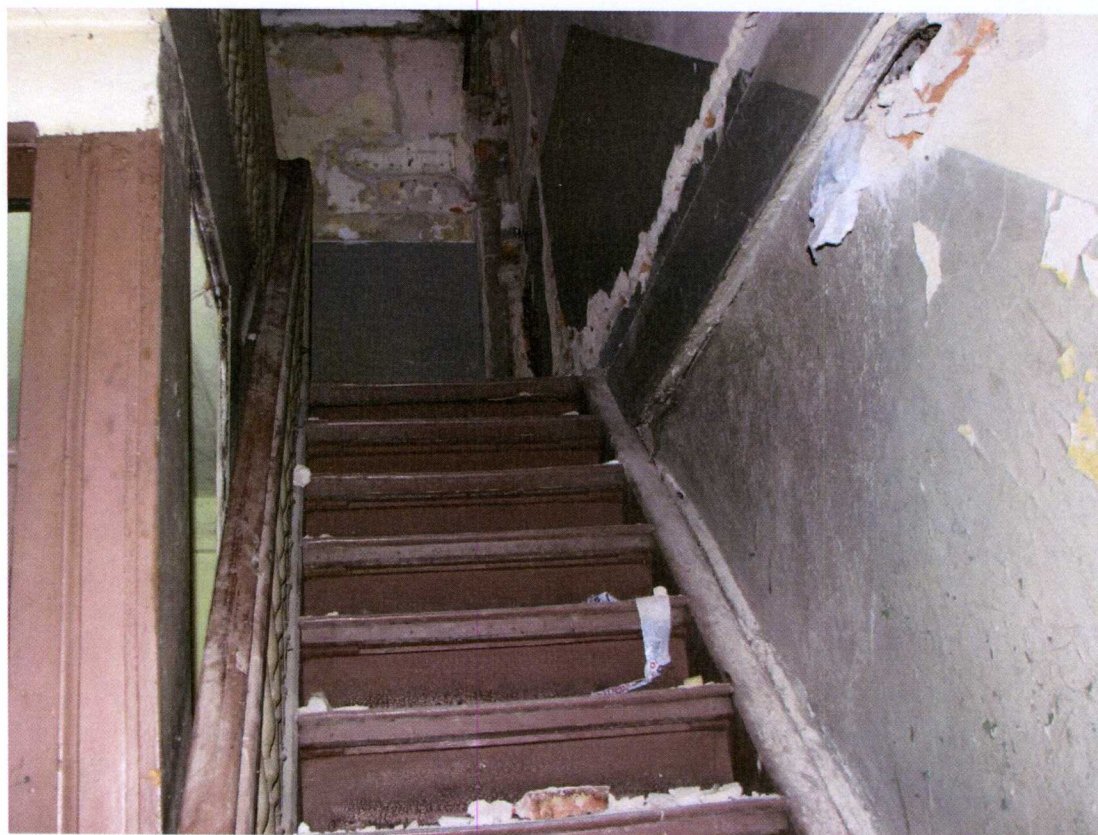
Foto.8 Widok klatki schodowej
