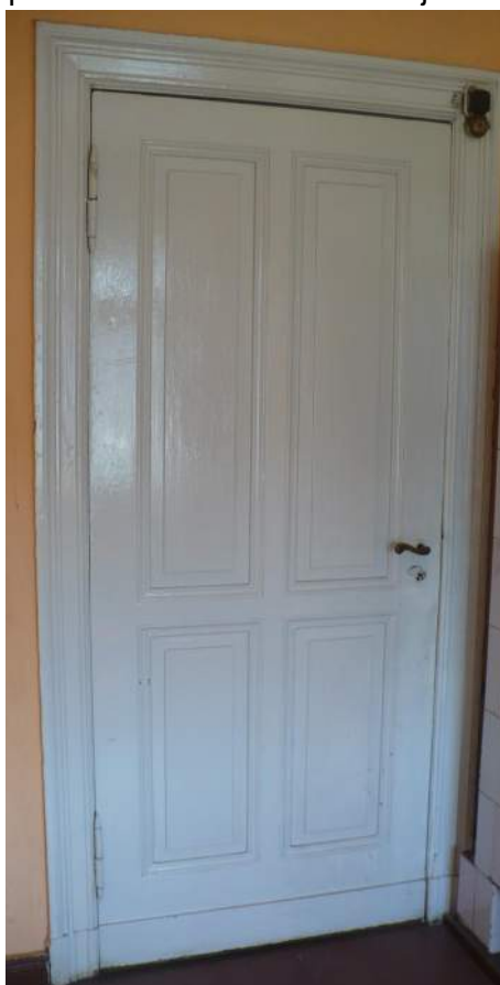
Stolarka drzwiowa D3 przeznaczona do konserwacji
