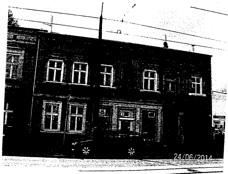
Fot. 1. Elewacja północna (frontowa) budynku.
