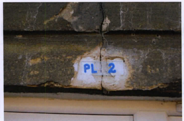
Fot. 31-32. Nieuszkodzony stan w grudniu 2014 r szklanych „plomb” założonych na pęknięciach nadproży w maju 2014 r. (przykładowo).
