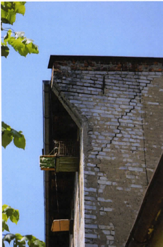
Fot. 11. Ścianka attykowa bud. 2c od południa.
