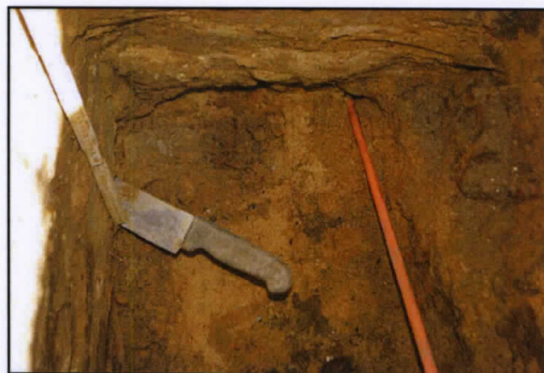
Fotografie odkrywki (po lewej ściana fundamentowa budynku Wojska Polskiego 2b (nóż) , po prawej budynku 2c).
