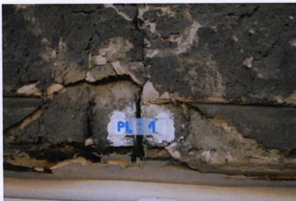
Fot. 31-32. Nieuszkodzony stan w grudniu 2014 r szklanych „plomb” założonych na pęknięciach nadproży w maju 2014 r. (przykładowo).
