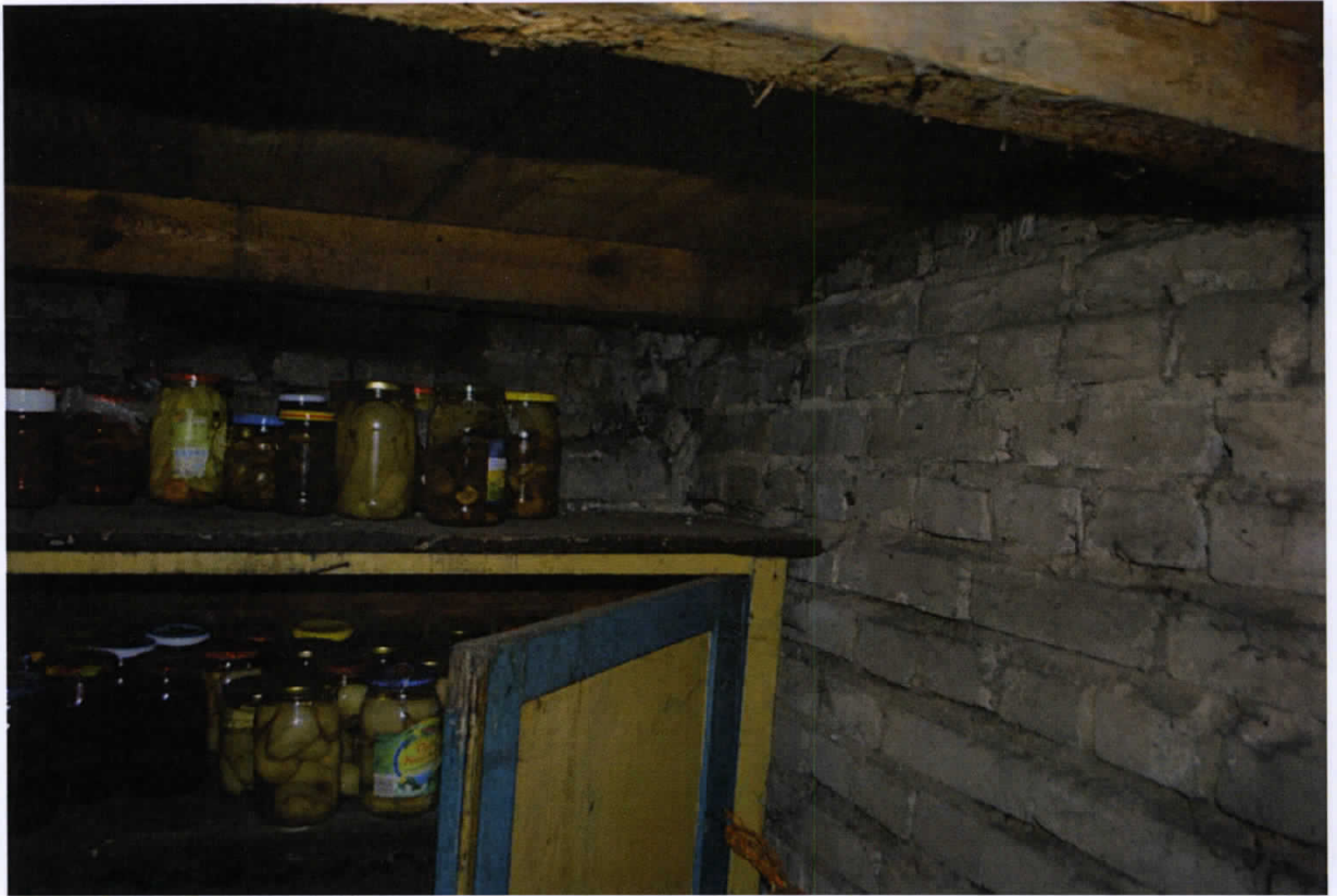
Fot. 23. Piwniczka lokatorska pod podłogą parteru w klatce schodowej budynku 2b.
