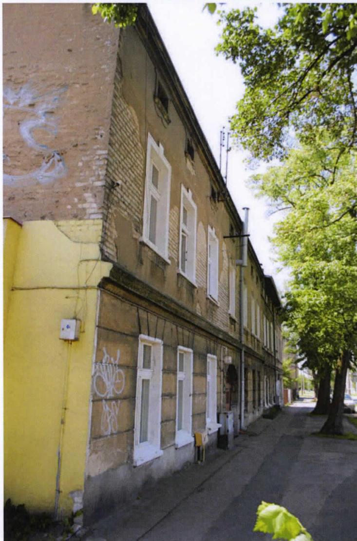
Fot. 1 i 2. Widok ogólny budynków przy ul. Wojska Polskiego 2 b i 2c od strony frontowej.
