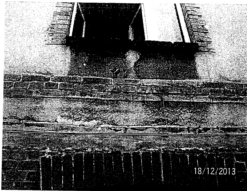
Fot.7. Pęknięcie na powierzchni tylnej ściany budynku.
