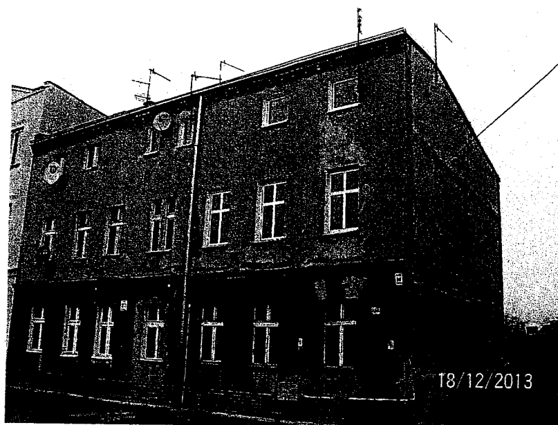
Fot. 1. Elewacja południowa i wschodnia
