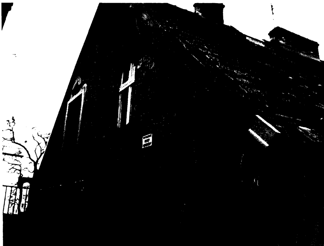
Foto.2 Szubińska 11 - widok na ścianę szczytową
