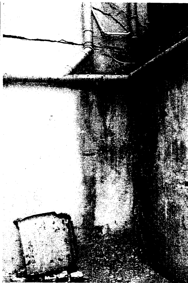
ODSPOJENIE "TAPNIETET" " ŚCIENNY POD PODCIĄGIEM OD STRUK POD WÓRZA "
