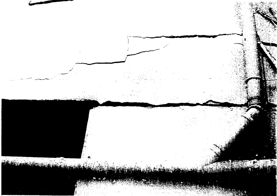
TAPNIĘCIE ŚCIANY POD PODCIĄGIEM. PEKNIĘCIA ŚCIANY NAD PODCIĄGIEM
