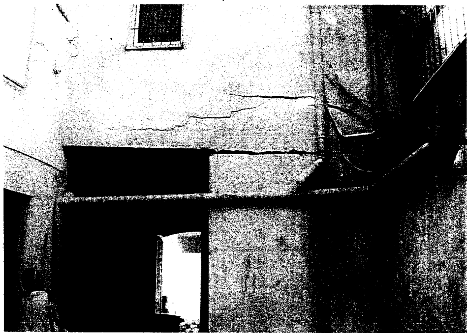
TAPNIĘCIE ŚCIANY POD PODCIĄGIEM. PEKNIĘCIA ŚCIANY NAD PODCIĄGIEM
