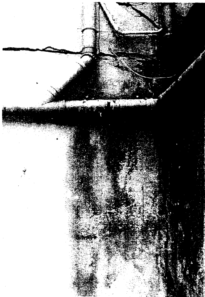
ODSPOJENIE "TAPNIETET" " ŚCIENNY POD PODCIĄGIEM OD STRUK POD WÓRZA "
