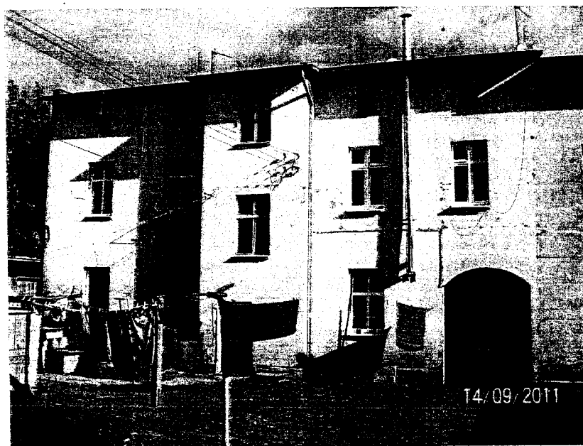
Fot. 2. Budynek frontowy - elewacja południowa (tylna).
