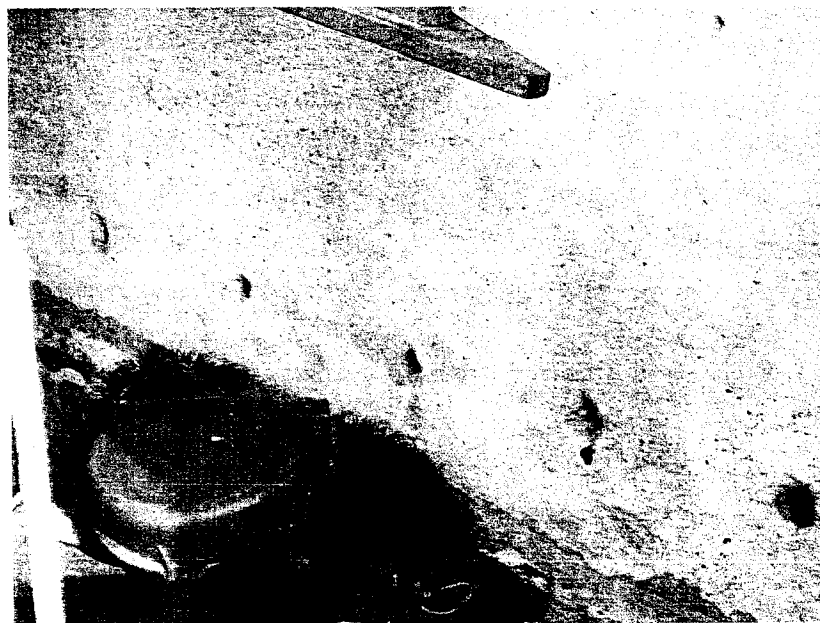
Fot. 8. Otwory do wykonania iniekcji.
