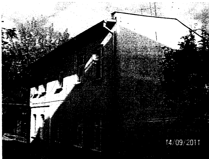
Fot. 4. Oficyna – widok od strony południowo-wschodniej
