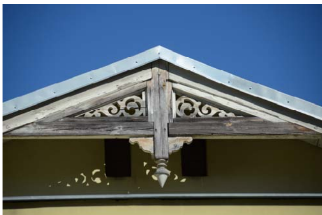
Szczyt na elewacji południowej.
