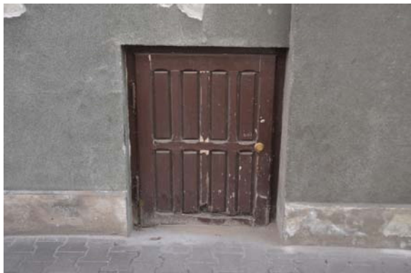
Drzwiczki pod schodami.
