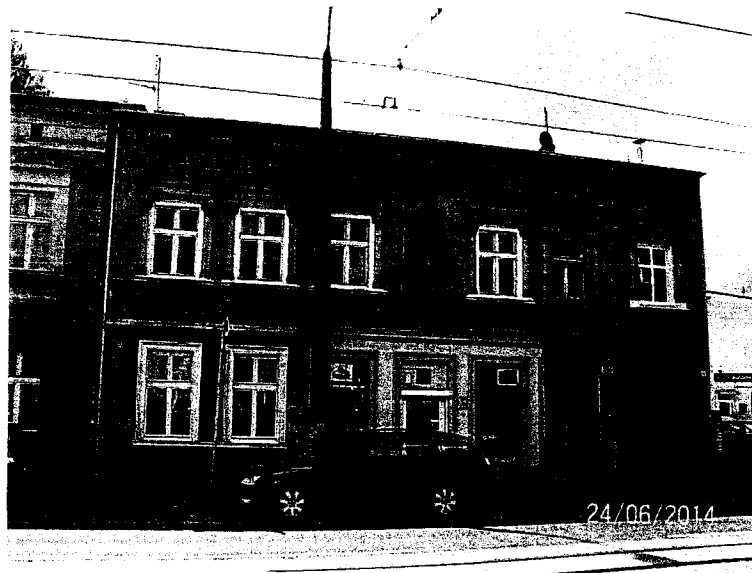
Fot. 1. Elewacja północna (frontowa) budynku.
