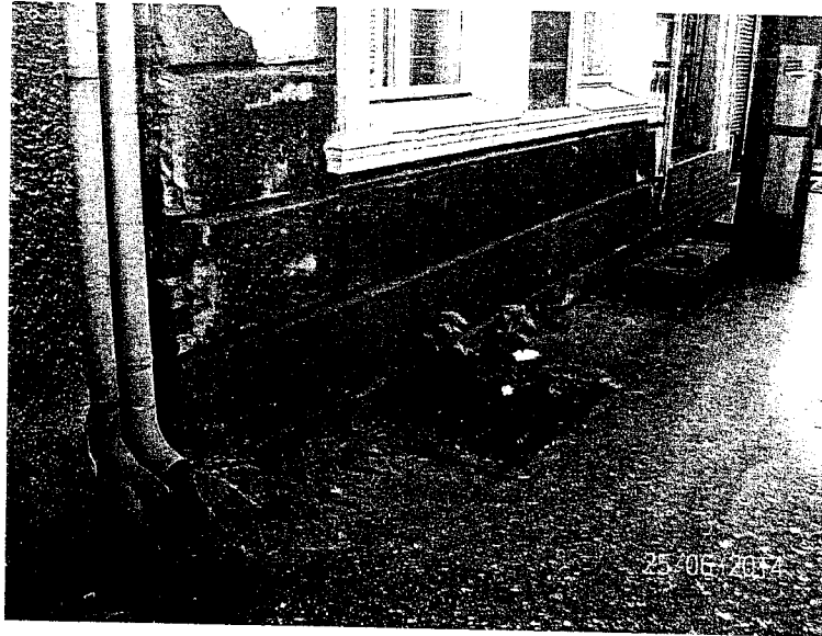
Fot.3. Rury spustowe w sąsiedztwie elewacji frontowej budynku.
