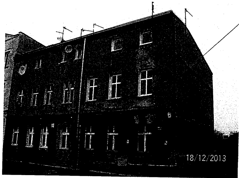
Fot. 1. Elewacja południowa i wschodnia
