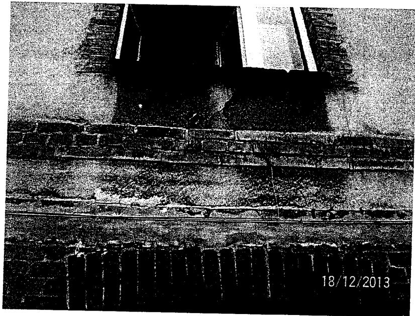
Fot.7. Pęknięcie na powierzchni tylnej ściany budynku.
