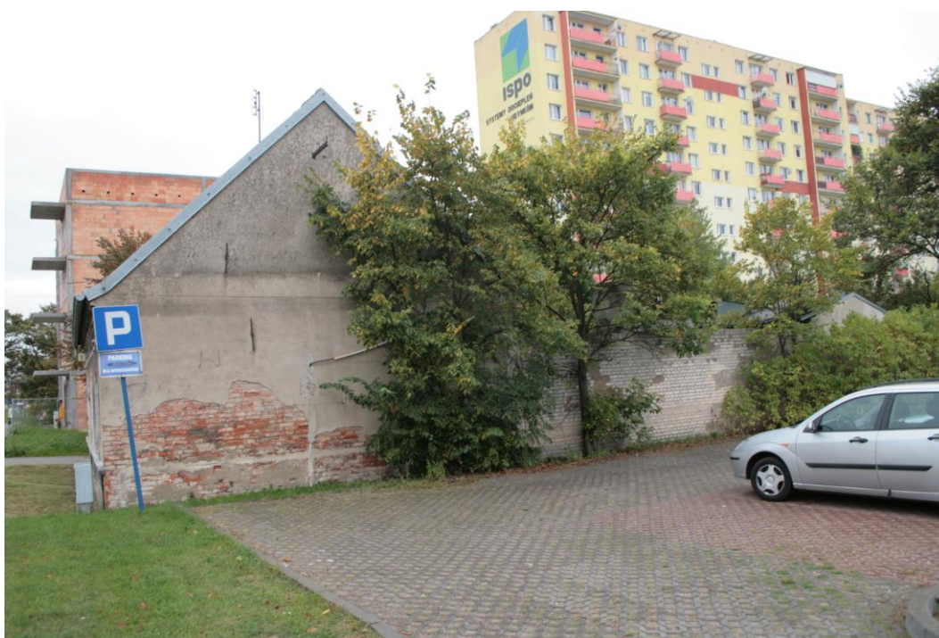
Elewacja zachodnia budynków
