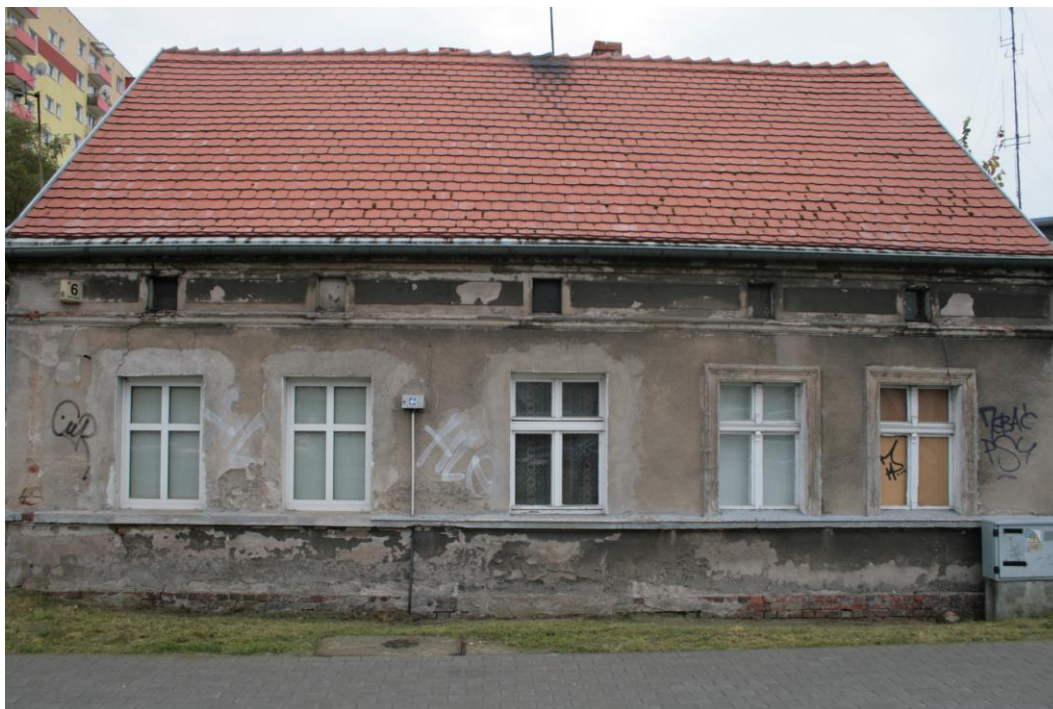
Budynek mieszkalny (frontowy) – elewacja północna ul. Wojska Polskiego 6, Bydgoszcz
