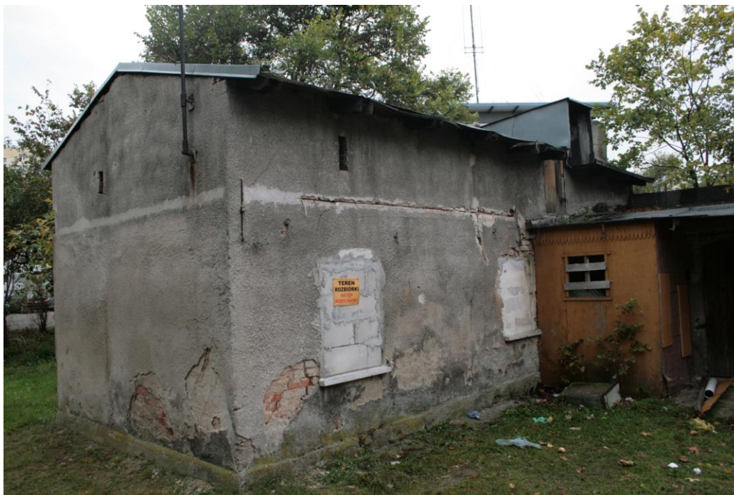
Elewacja północna (podwórkowa) budynku oficyny (OF1)
