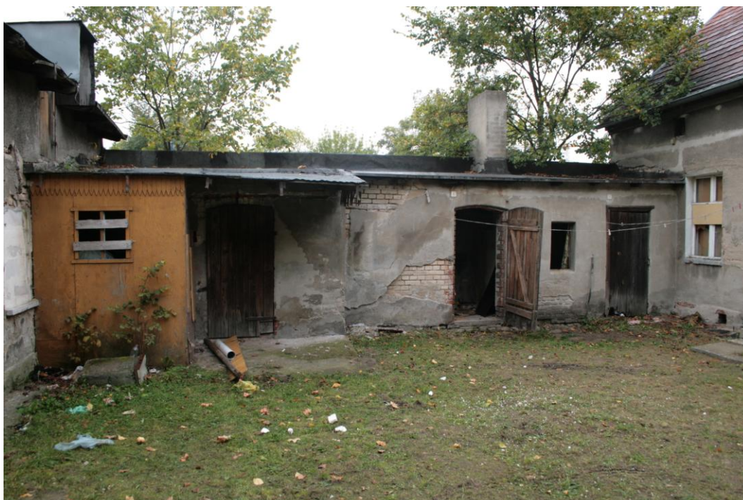
Elewacja wschodnia (podwórkowa) budynku gospodarczego
