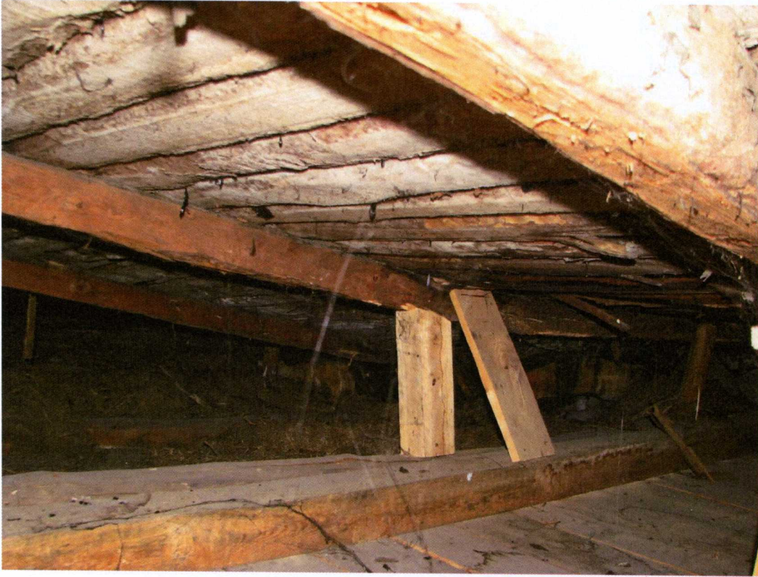
Foto.5 Widok na poddasze nieużytkowe
