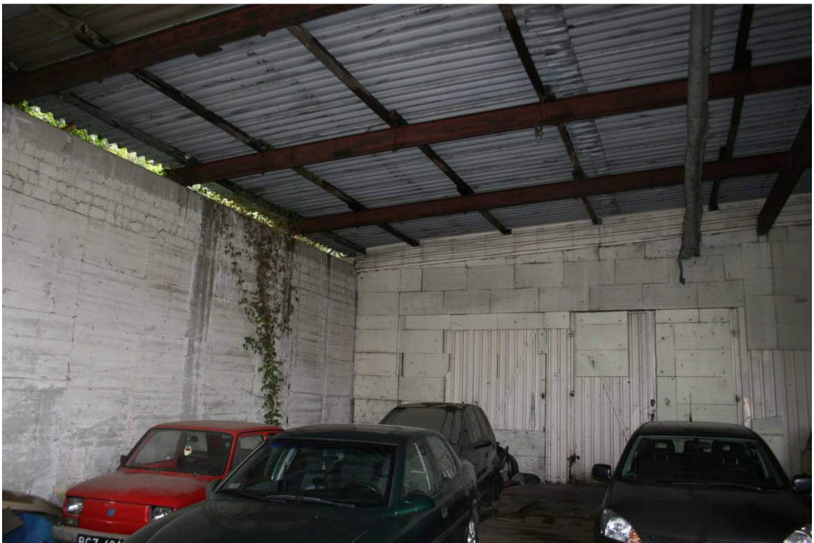
Wiata stalowa obudowana elewacja zachodnia
