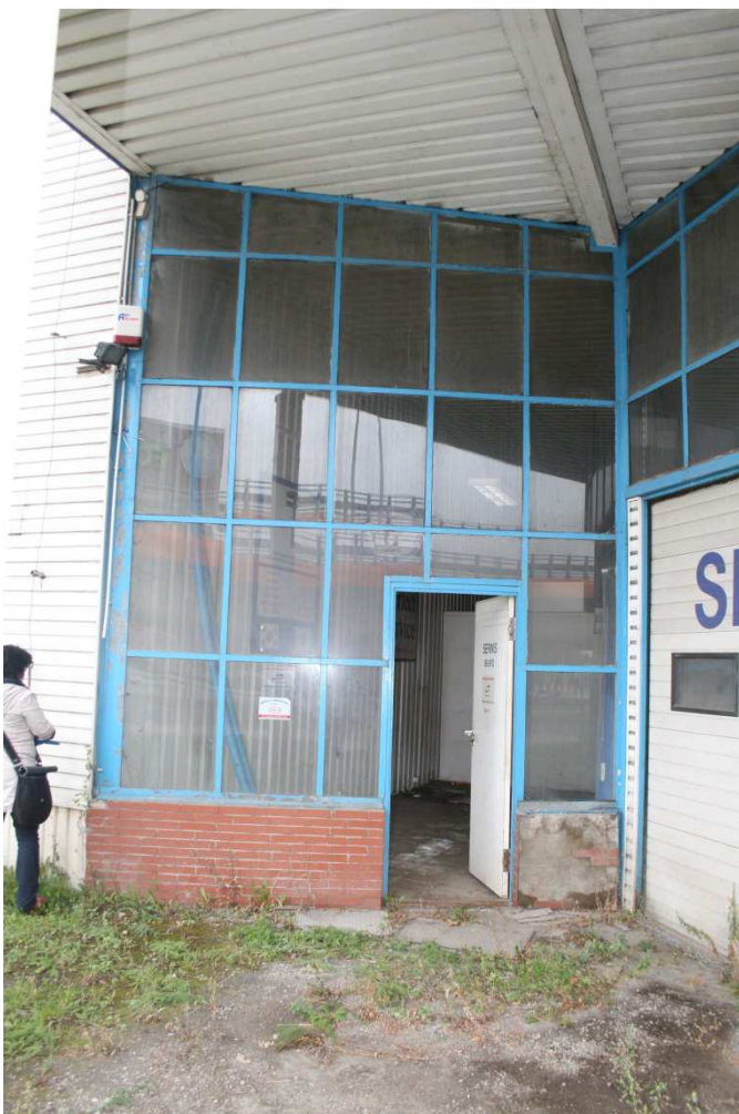
Wiata stalowa obudowana elewacja wschodnia.
