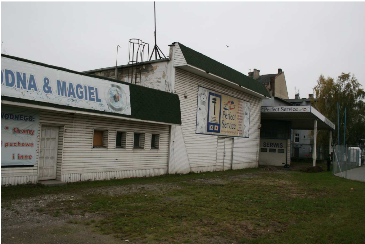
Wiata stalowa obudowana elewacja wschodnia
