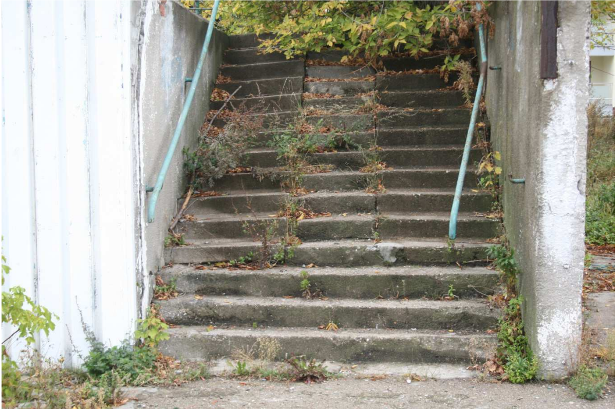
Schody na elewacji wschodniej
