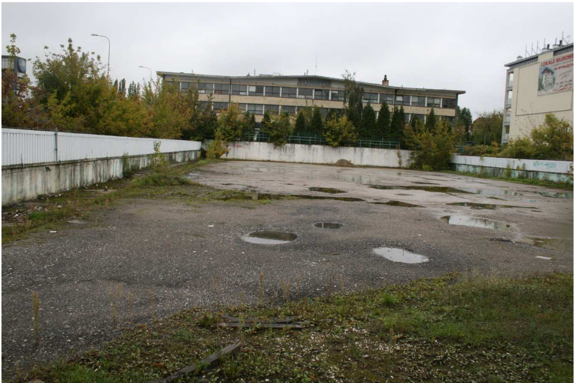
Płyta betonowa otwarta – elewacja północna.
