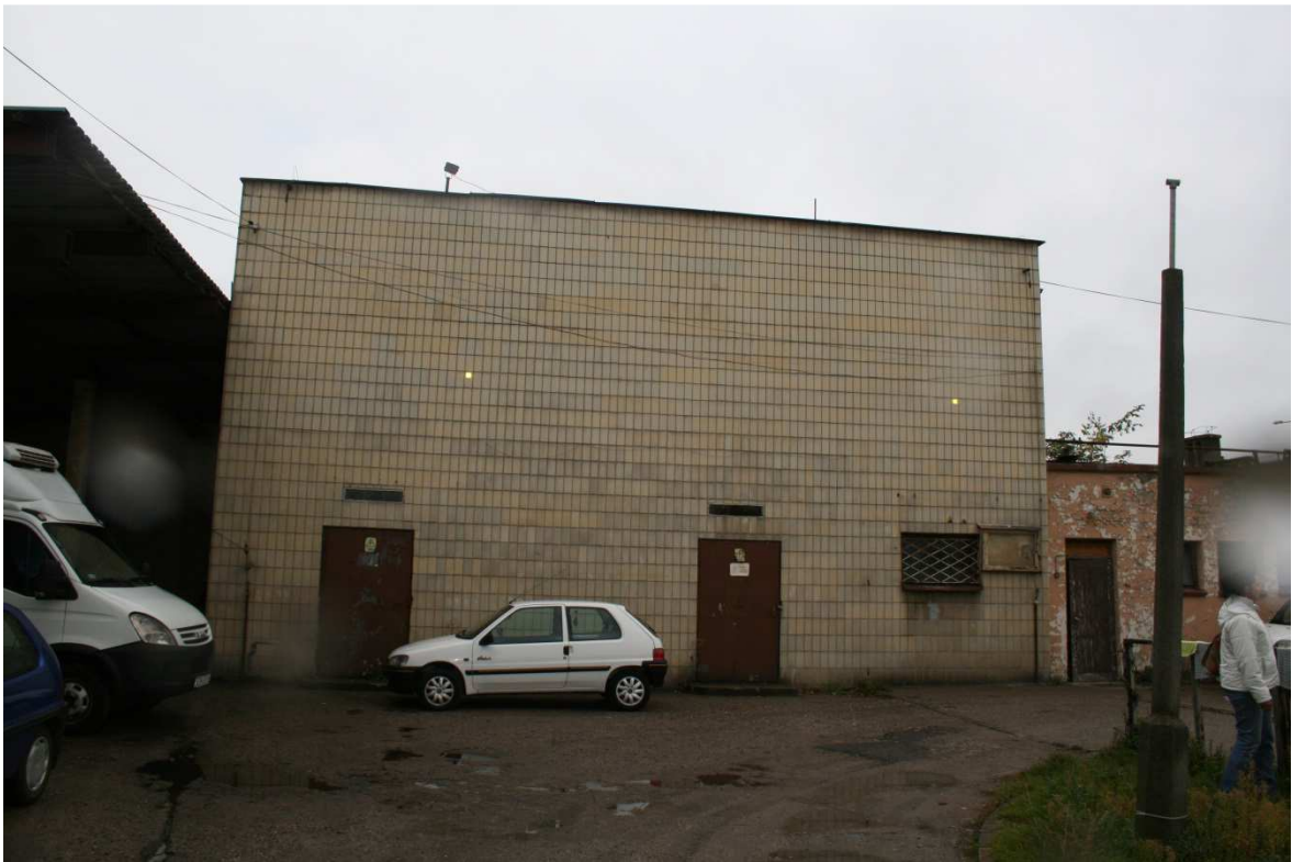
Maszynownia ziębnicza – elewacja wschodnia.
