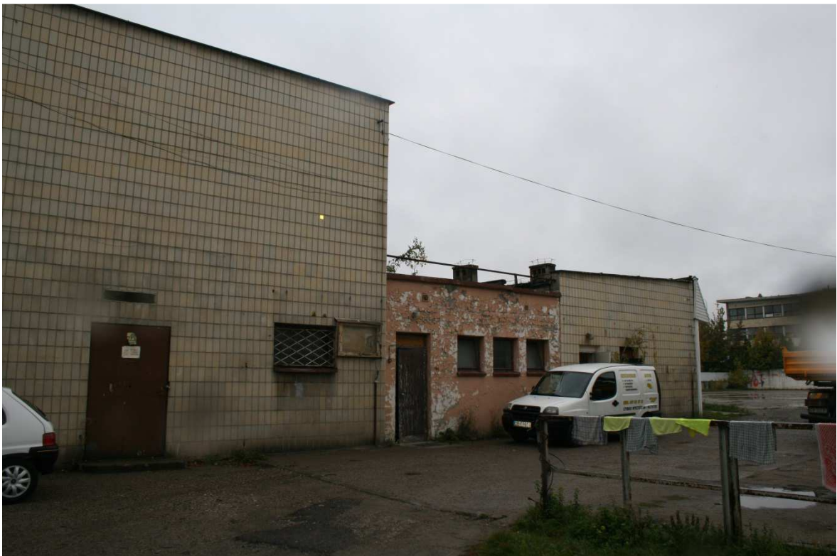
Maszynownia ziębnicza i atrium – elewacja wschodnia
