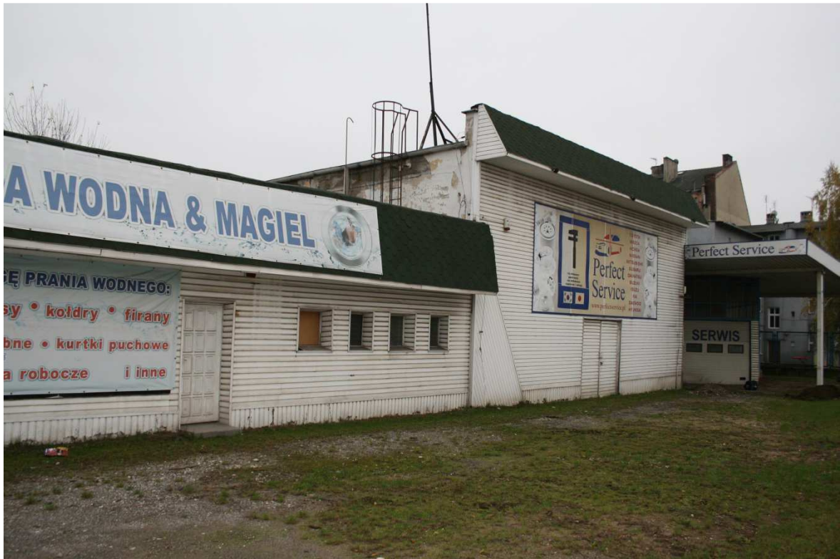
Elewacja zachodnia budynek ogólnodostępny, atrium i maszynownia ziębnicza.
