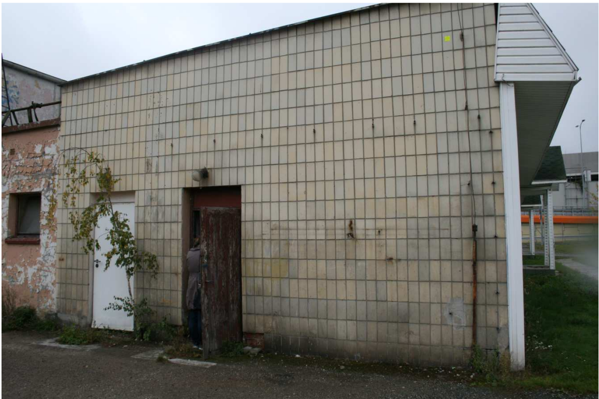
Budynek ogólnodostępny elewacja wschodnia.
