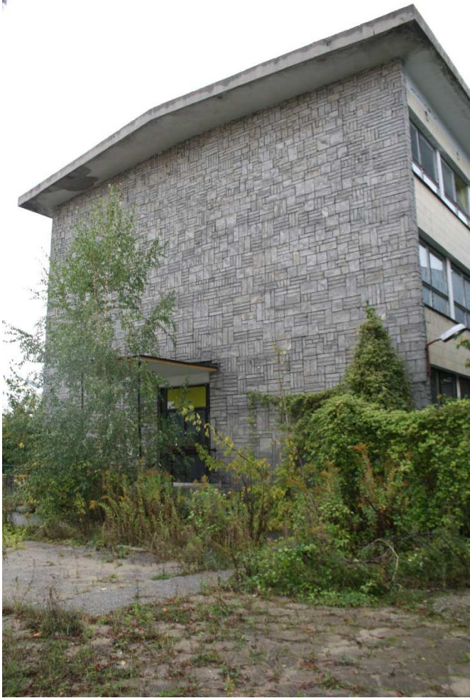
Budynek hotelowy – elewacja wschodnia
