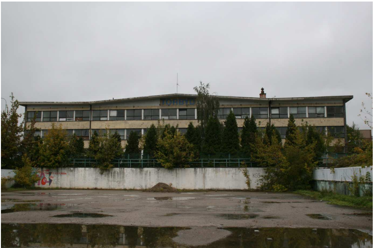
Budynek hotelowy – elewacja południowa
