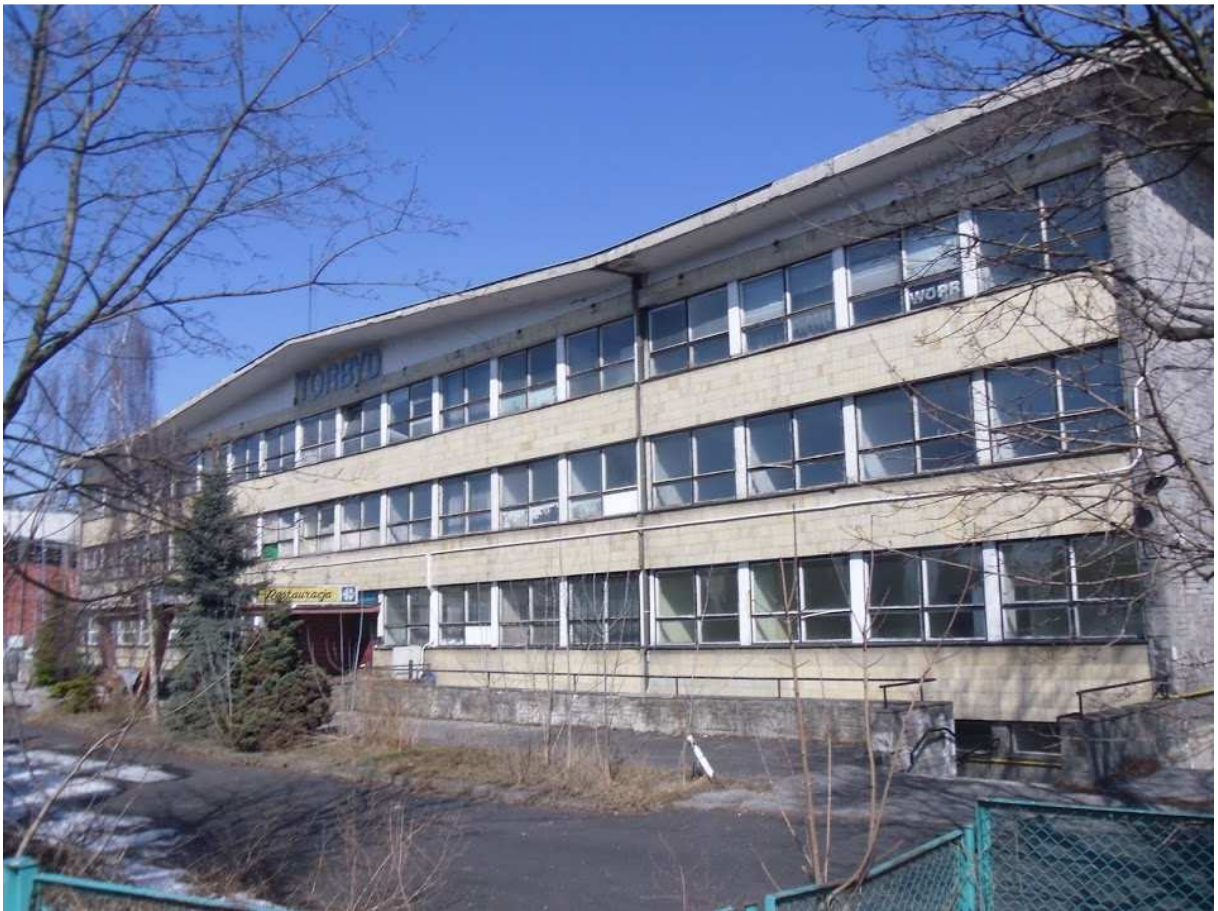
Budynek hotelowy – elewacja południowa
