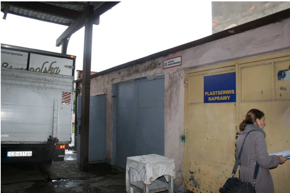
Garaż murowany – elewacja zachodnia
