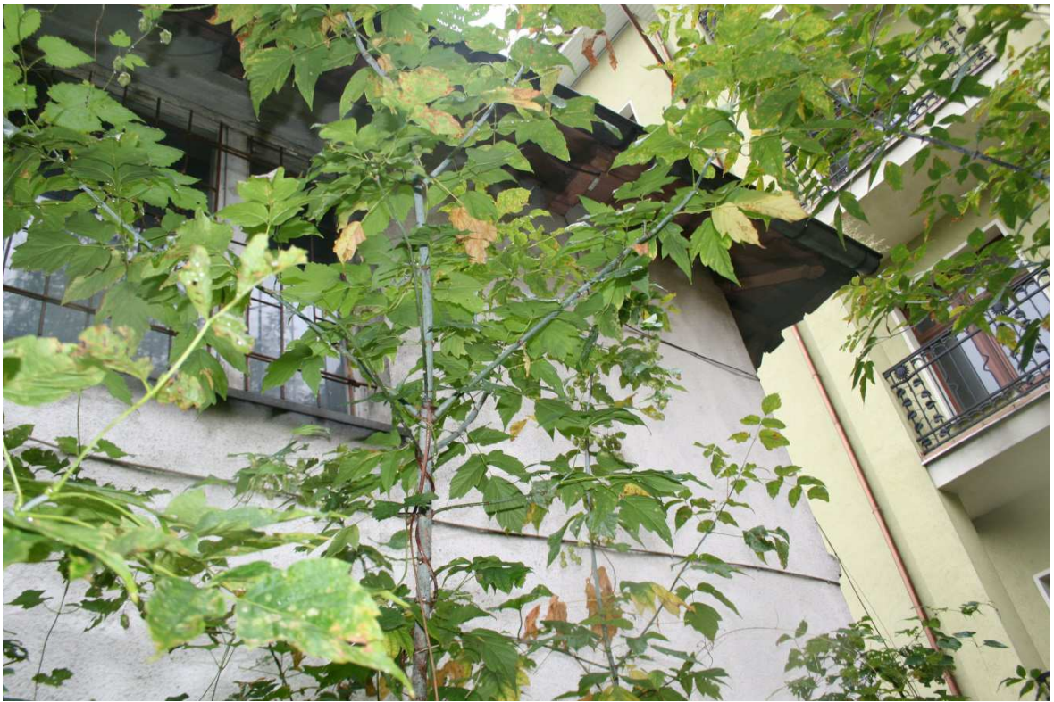
Fragment elewacji zachodniej – okno na I piętrze.
