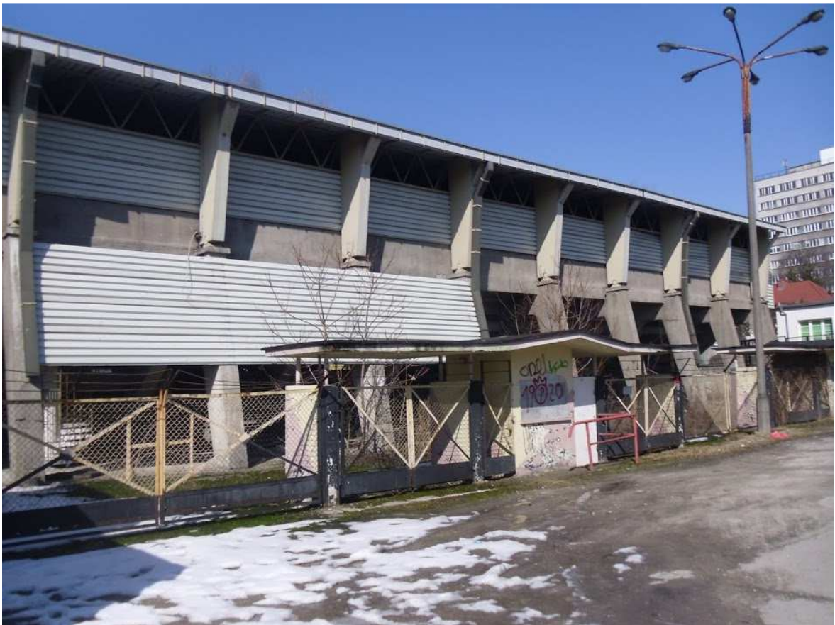
Kasy – elewacja wschodnia
