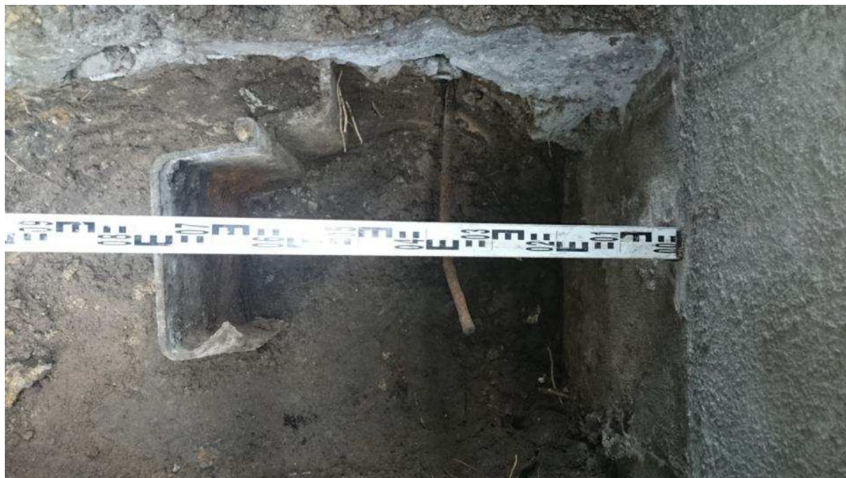
Fotografia 11. Pomiar odległości ścianki od muru w odkrywcę nr 2.
