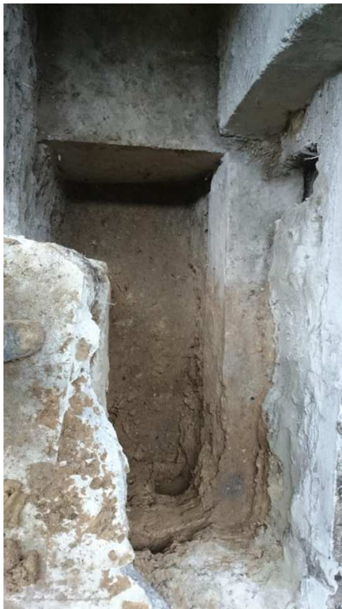
Fotografia 2. Rzut z góry odsłoniętej części fundamentu w odkrywce nr 1.
