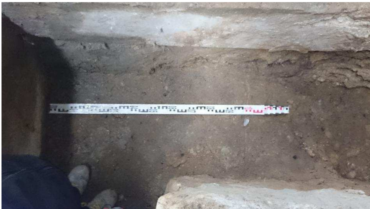
Fotografia 7. Pomiar szerokości góry stopy fundamentowej w odkrywce nr 1.
