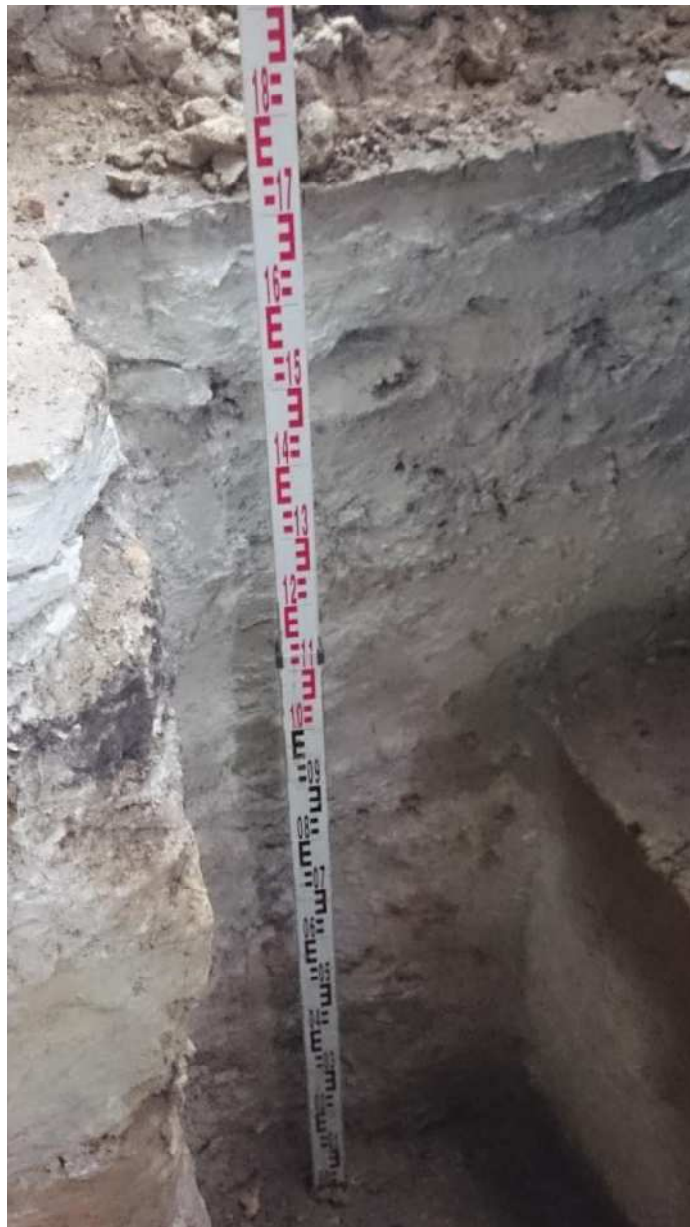
Fotografia 4. Pomiar głębokości góry fundamentu od powierzchni posadzki w odkrywce nr 1.
