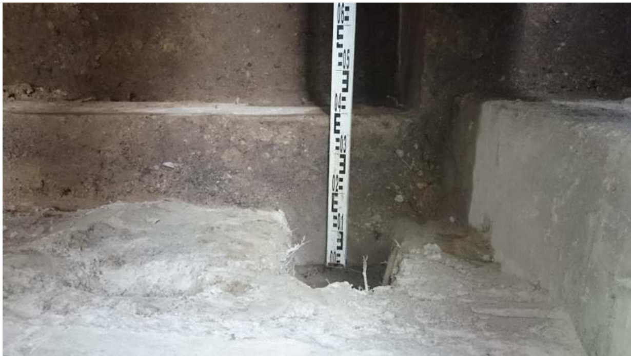
Fotografia 5. Pomiar szerokości ławy w odkrywce nr 1.
