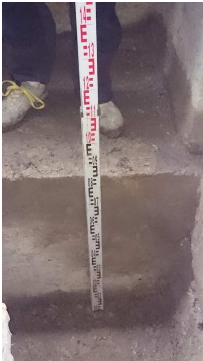
Fotografia 3. Pomiar wysokości ławy fundamentowej w odkrywce nr 1.
