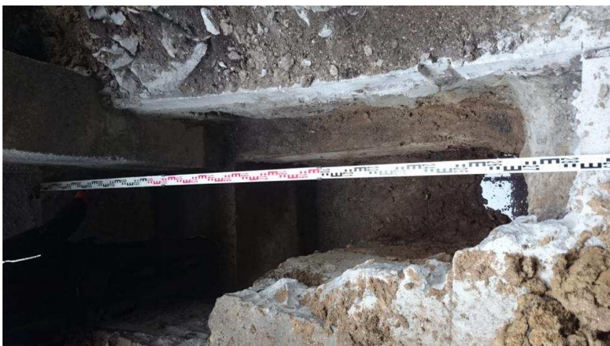
Fotografia 8. Pomiar długości odkrywki nr 1.
