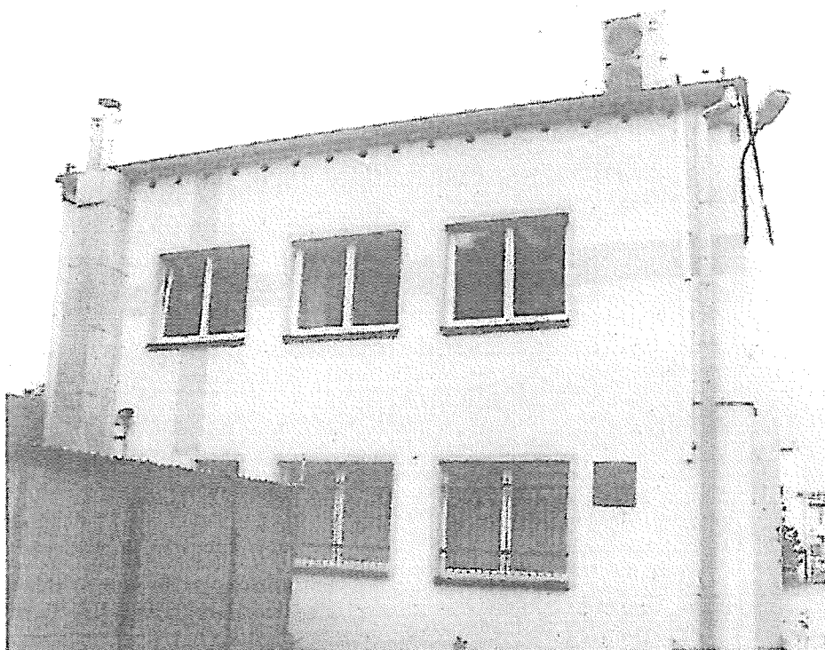
Fot.4.Ściana C. Fot. Bogdan Rudzionic
