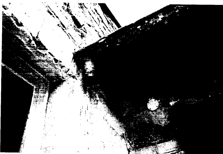
Połączenie budynku przeznaczanego do rozbiórki z budynkiem gospodarczym
