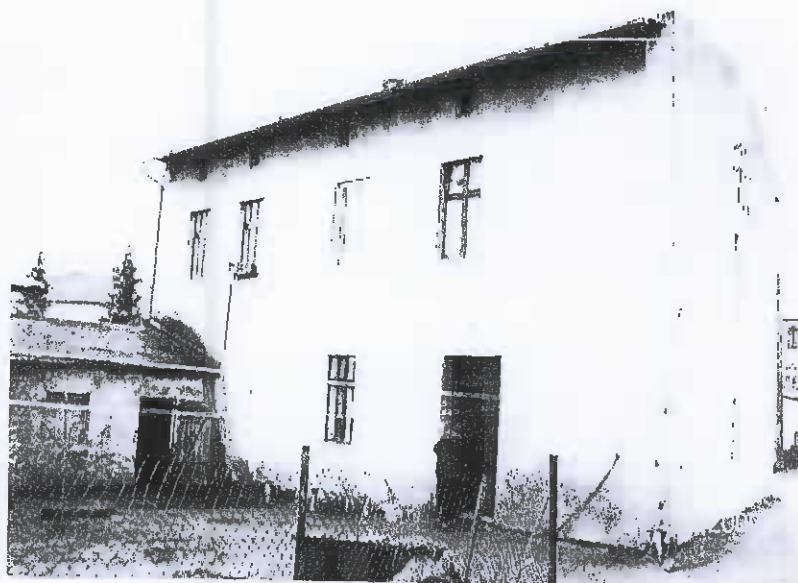
Fot. 2. Elewacja tylna (północno-zachodnia) budynku.
