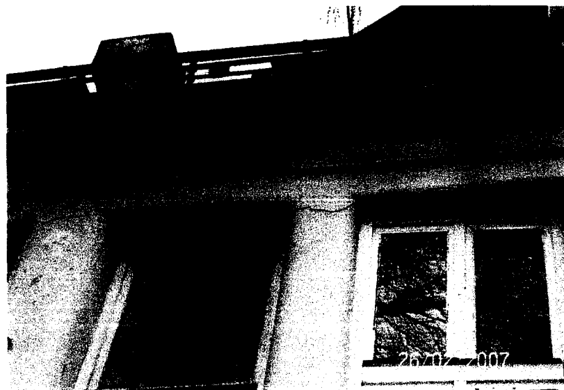
Fot. 5. Pęknięcie nadproża okiennego na elewacji tylnej.
