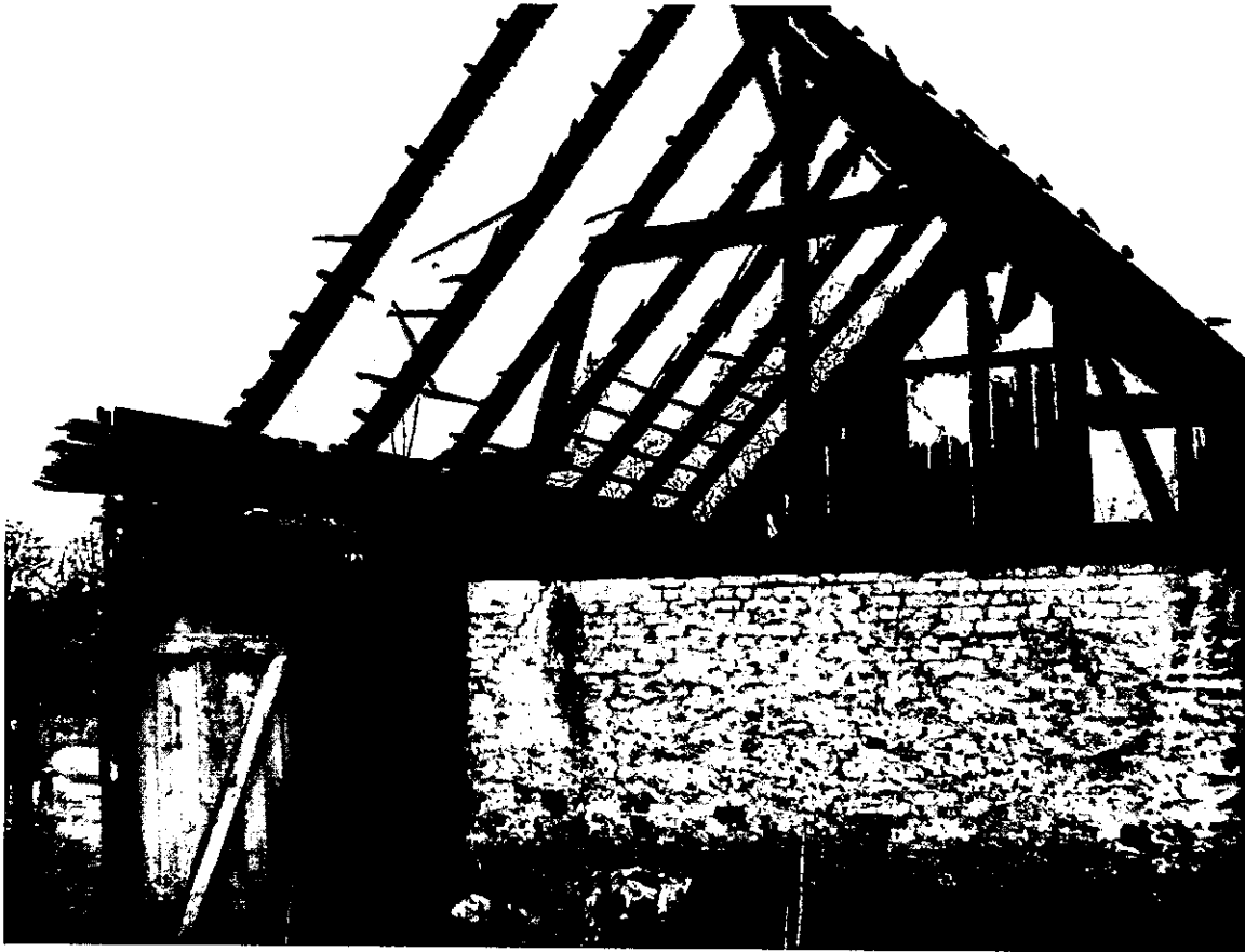
Foto.7 Widok od środka, część drewniana
