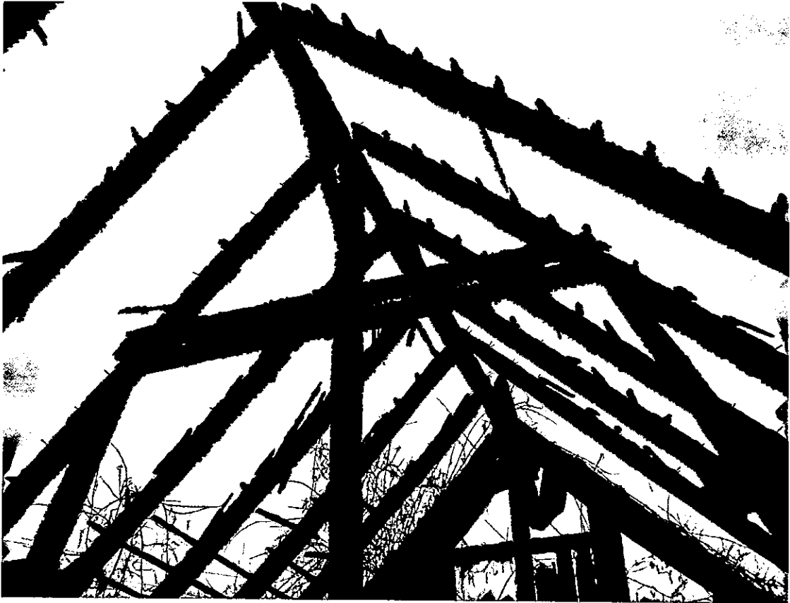
Foto.5 Konstrukcja dachu nad częścią murowaną
